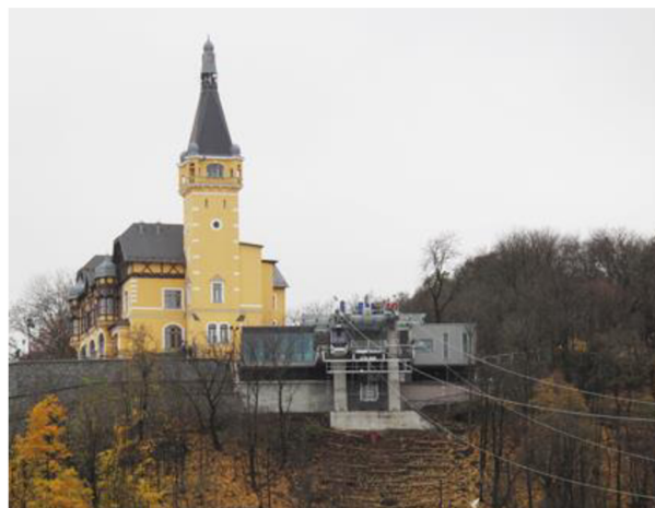
Obr. 31 Lanová dráha na Větruši v Ústí nad Labem
