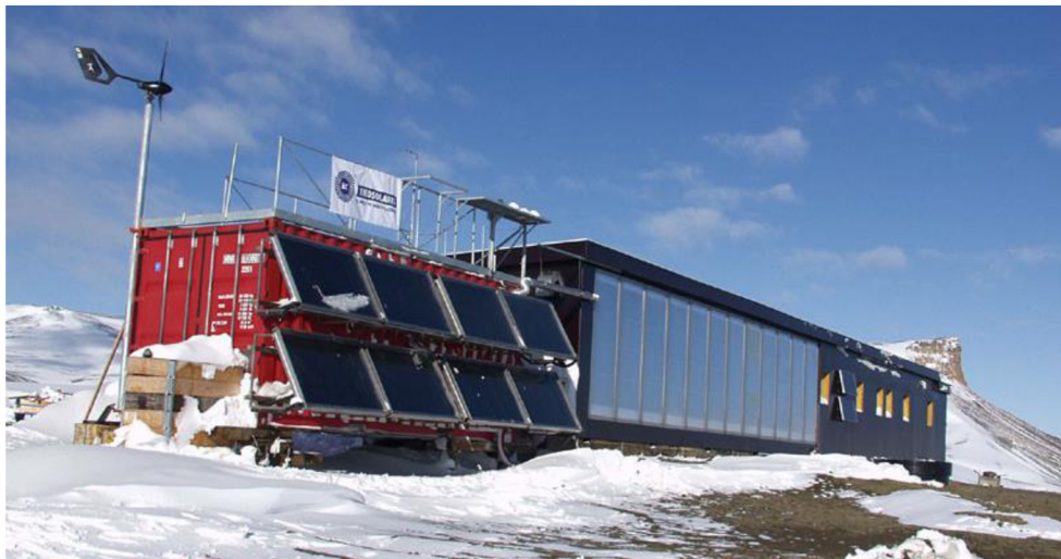
Obr. 4 Pohled na jižní fasádu s energetickými zdroji
