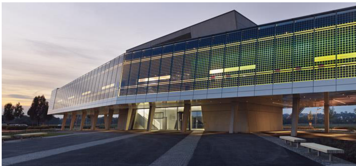
Obr. 7 Jižní fasáda s tenkovrstvými FV články v prosklených plochách
