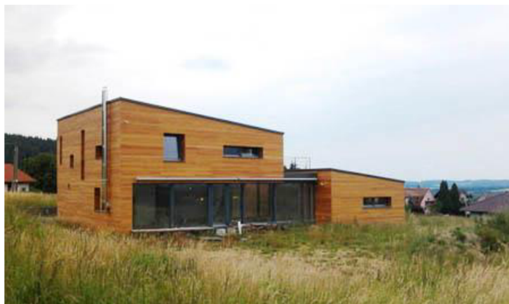
Obr. 22 Nízkoenergetický rodinný dům ve Frýdlantu nad Ostravicí
