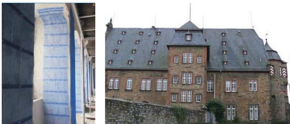
Obr. 22 Kapilární rohože na zámku Solms, Butzbach, Německo [19]
