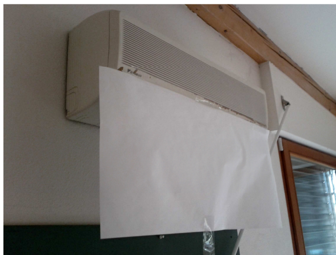
Obr. 5 Obtěžování průvanem u chladivových jednotek a jeho časté „řešení“ [Autor]
