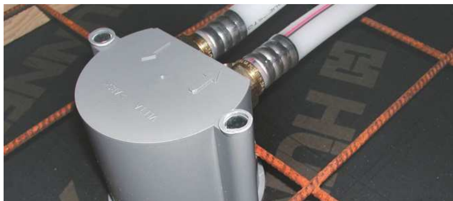
Obr. 19 Tepelná zásuvka [14]
