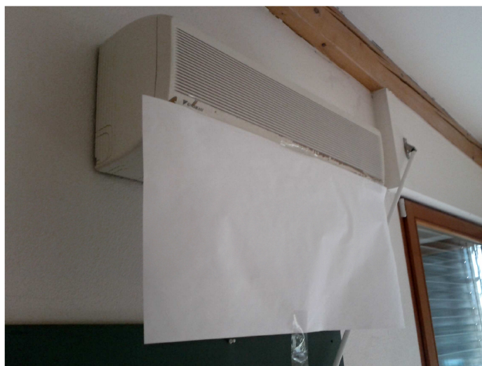
Obr. 5 Obtěžování průvanem u chladivových jednotek a jeho časté „řešení“ [Autor]
