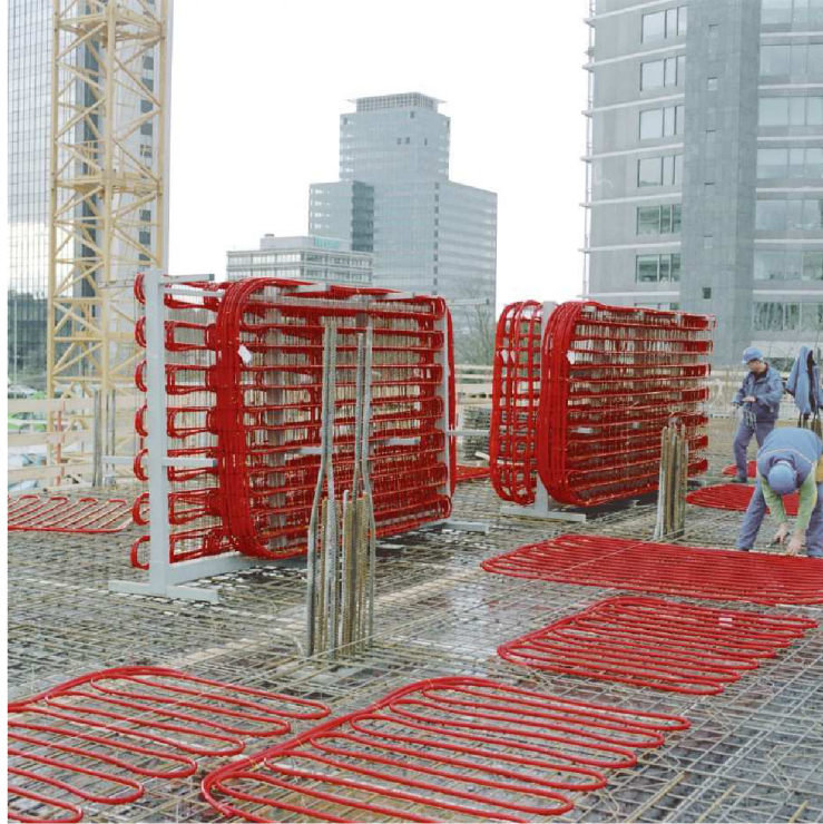
Obr. 20 Montáž tepelně aktivované stropní konstrukce [15]
