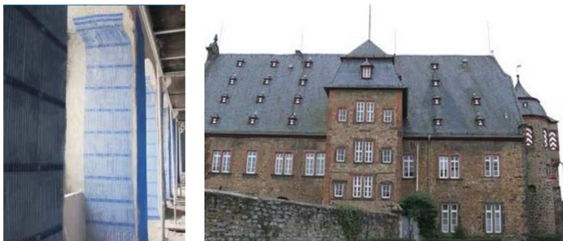
Obr. 22 Kapilární rohože na zámku Solms, Butzbach, Německo [19]
