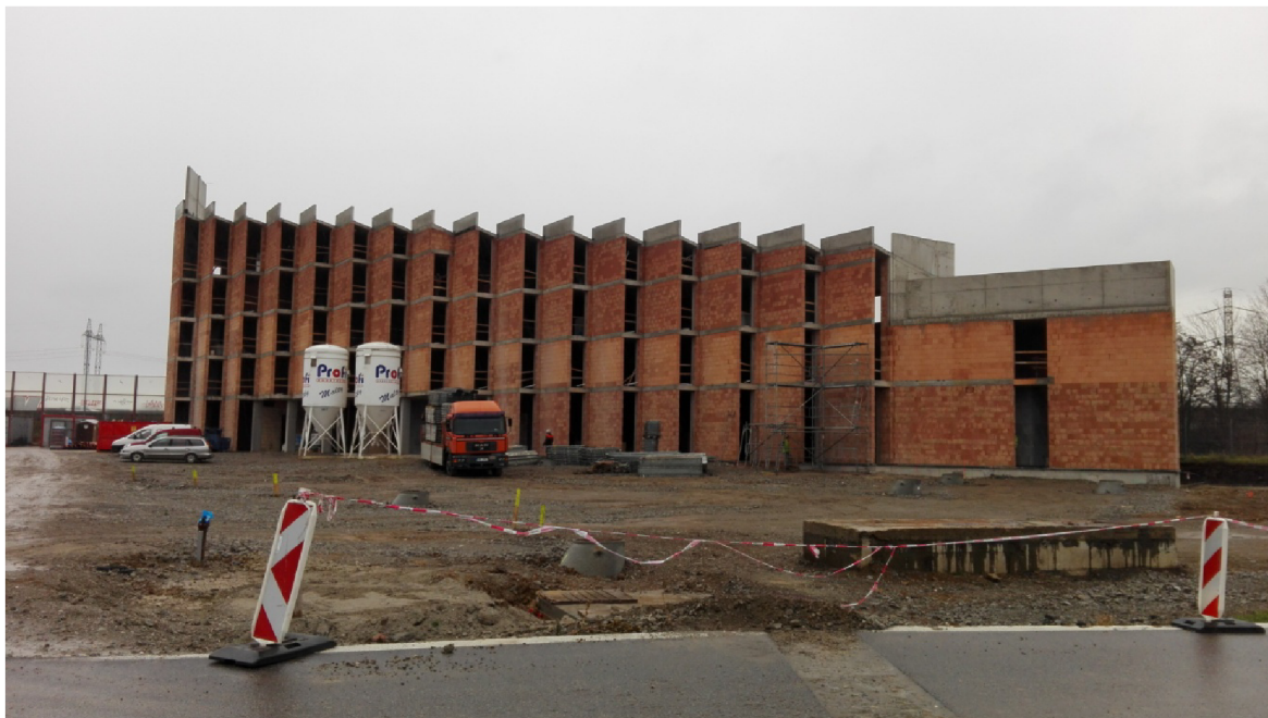
Obr. 24: Snímek rozestavěného hotelu dne 30.11.2015
