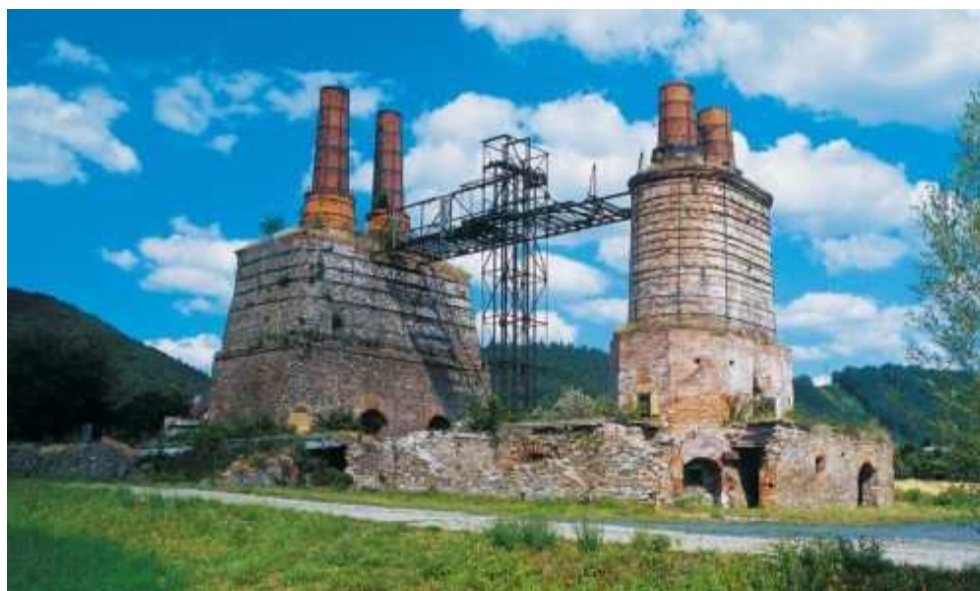
Obrázek 5: Berlova vápenka před rekonstrukcí [30]
