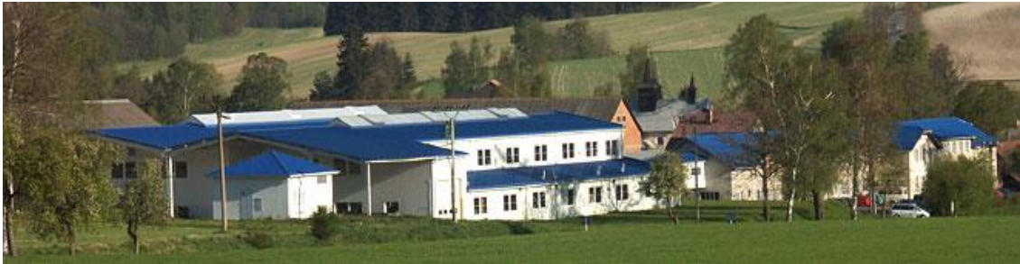
Obr. 2: Sídlo společnosti FLÍDR s.r.o. (19)
