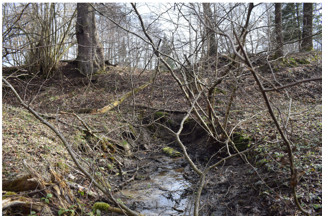
Vyústění potrubí spodní vypusti, březem 2023.
