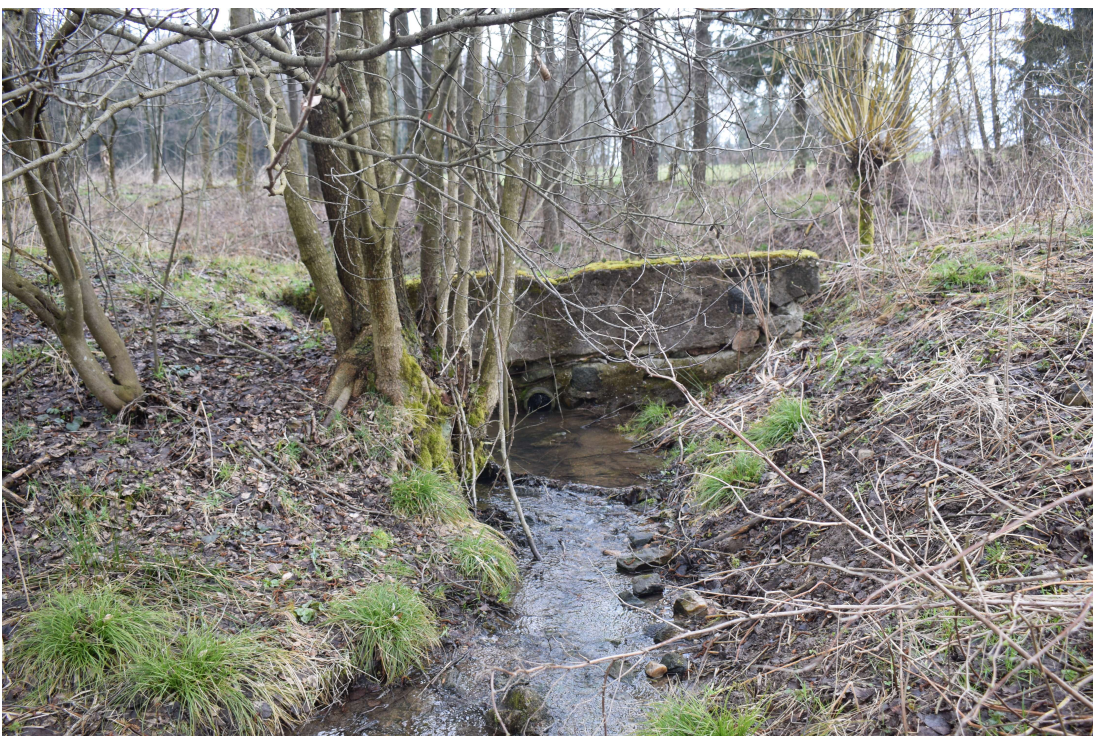
Objekt předzdrže, březen 2023.
