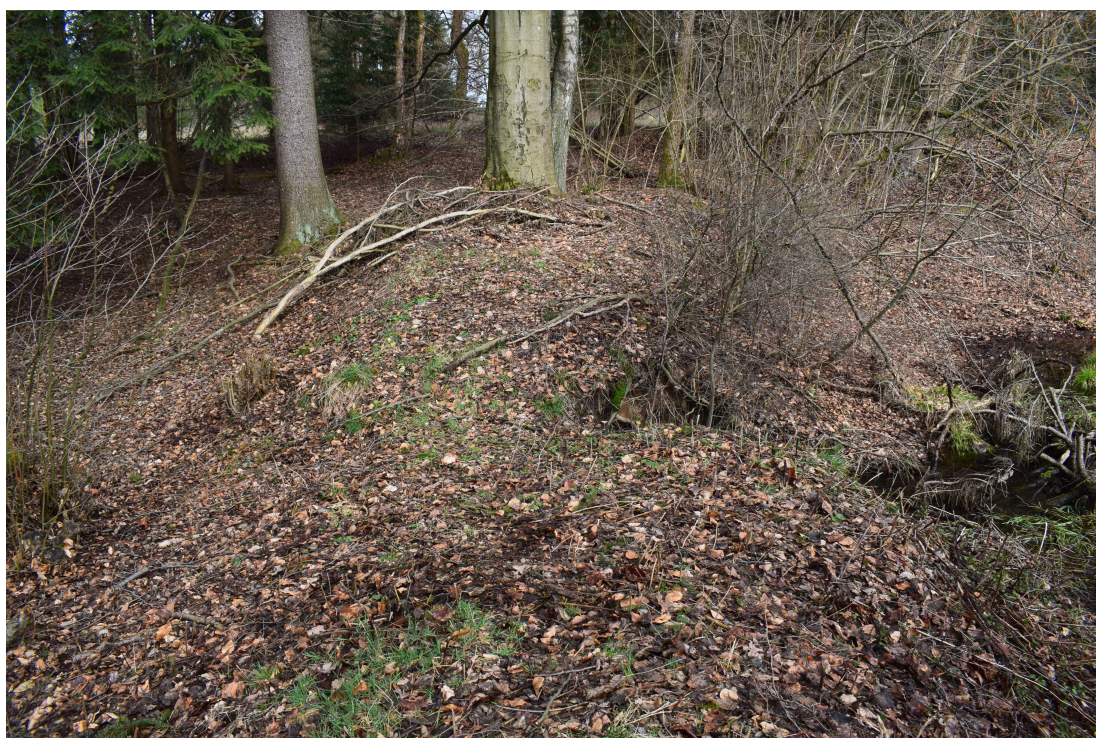
Nátrž hráze, březen 2023.
