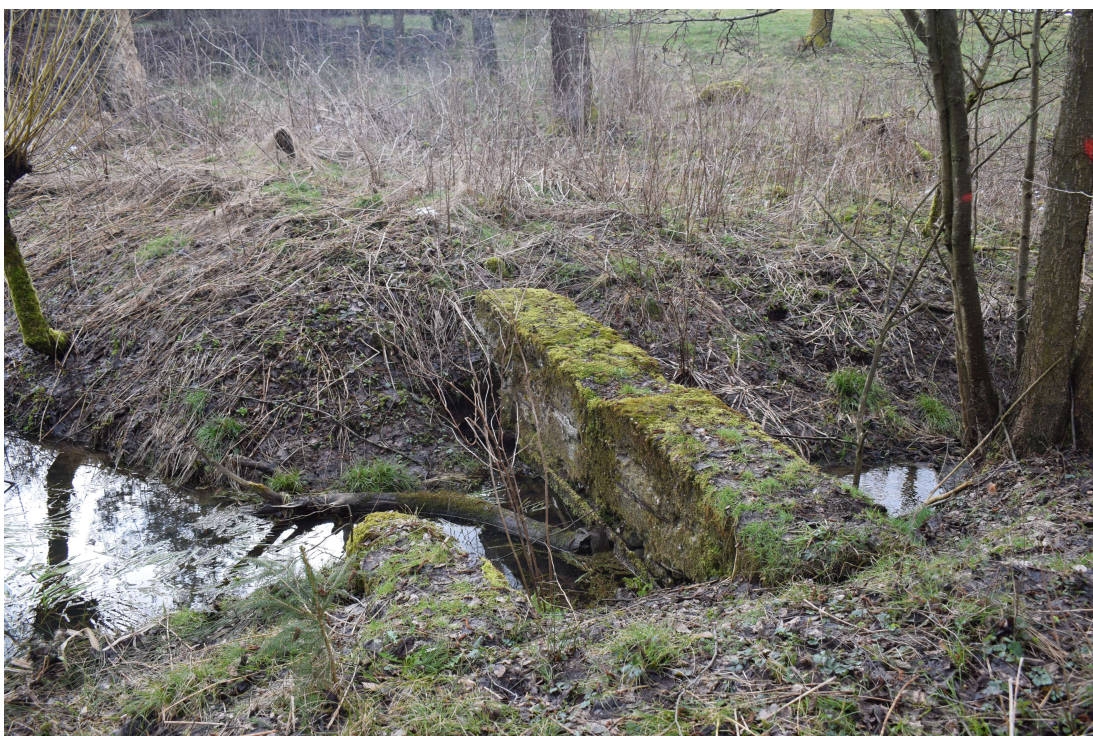
Objekt předzdrže, březen 2023.
