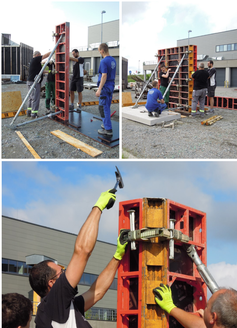
Obr. A.1: Montáž bednění pro svislý blok.
