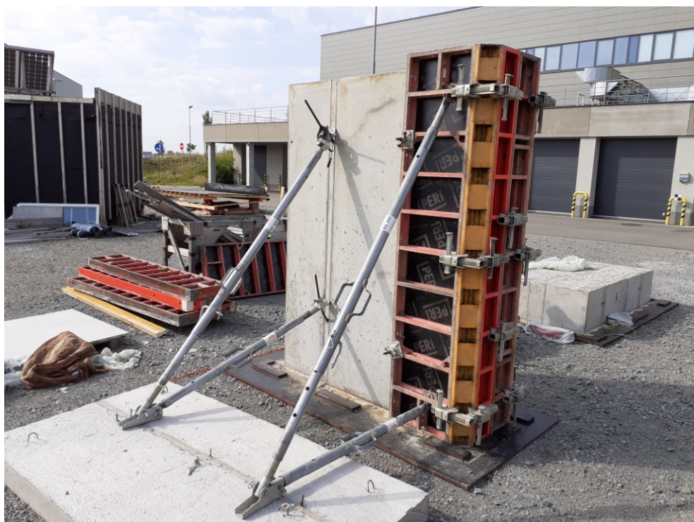
Obr. A.9: Odbednění svislého bloku.
