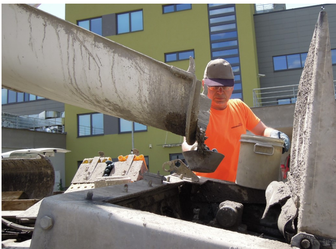
Obr. A.4: Odběr vzorku čerstvého betonu pro zkoušky.
