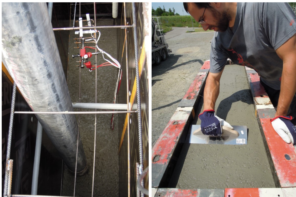
Obr. 2.4: Betonáž svislého bloku.
