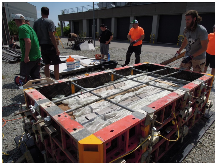
Obr. A.7: Ošetření bloků proti ztrátám vlhkosti.
