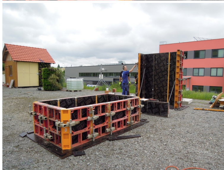
Obr. A.2: Montáž bednění pro vodorovný blok.
