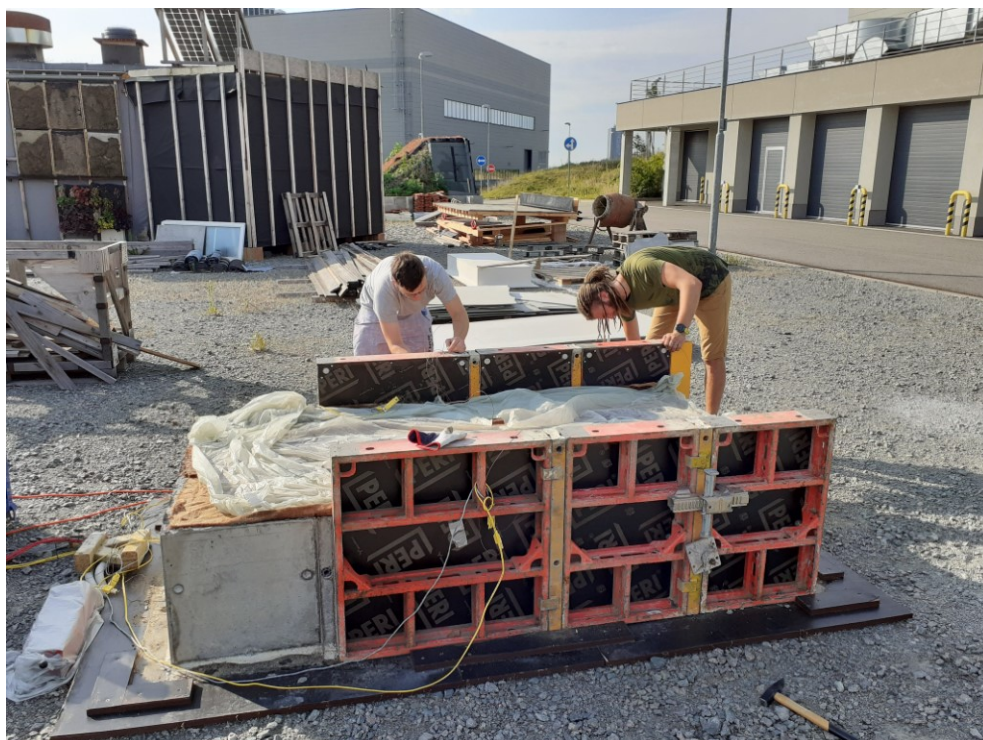
Obr. A.8: Odbednění vodorovného bloku.
