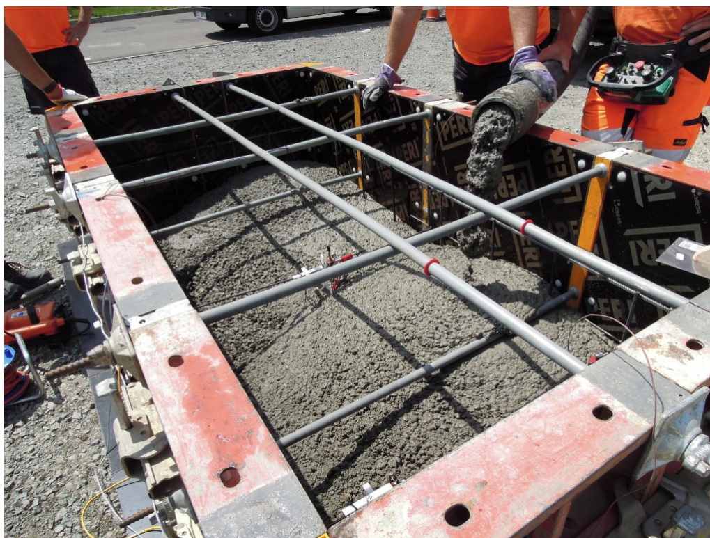
Obr. 2.4: Betonáž svislého bloku.
