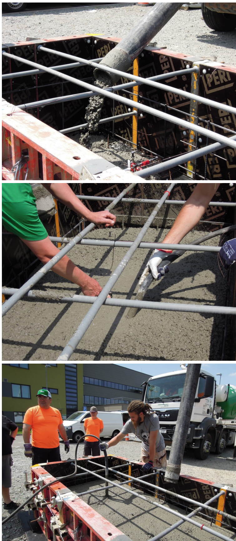
Obr. A.6: Betonáž a hutnění vodorovného bloku.
