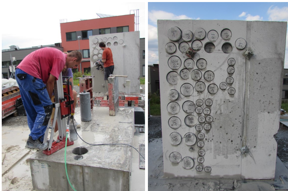
Obr. A.15: Odběr vývrtů.
