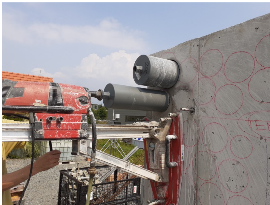
Obr. A.14: Odběr vývrtů ze svislého bloku.
