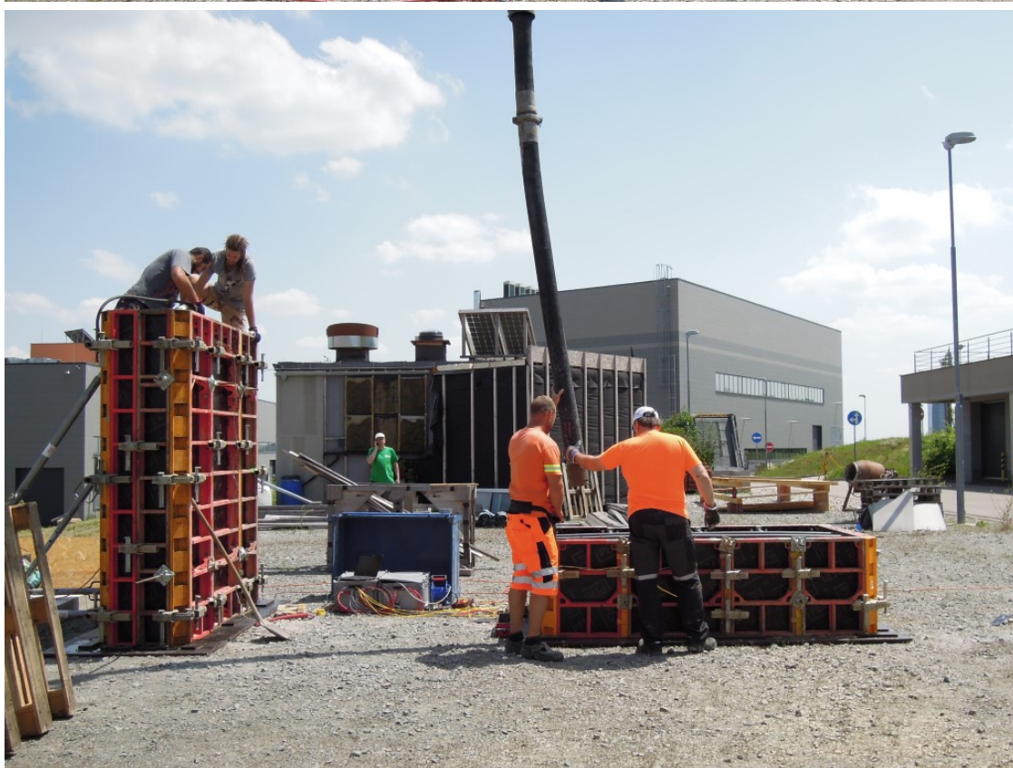
Obr. A.5: Betonáž bloků.
