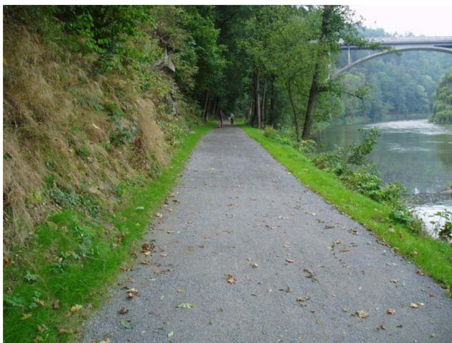
Obrázek 33: Dokončená oprava cesty
