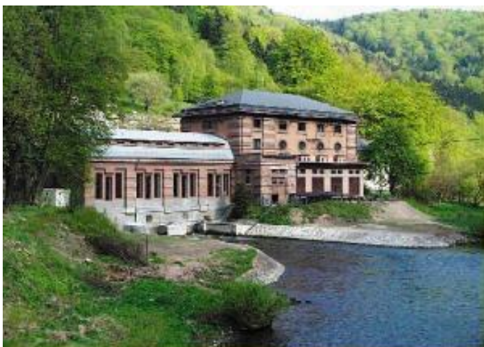
Obrázek 24 Budova elektrárny, Zdroj:(ČEZ, no date)
