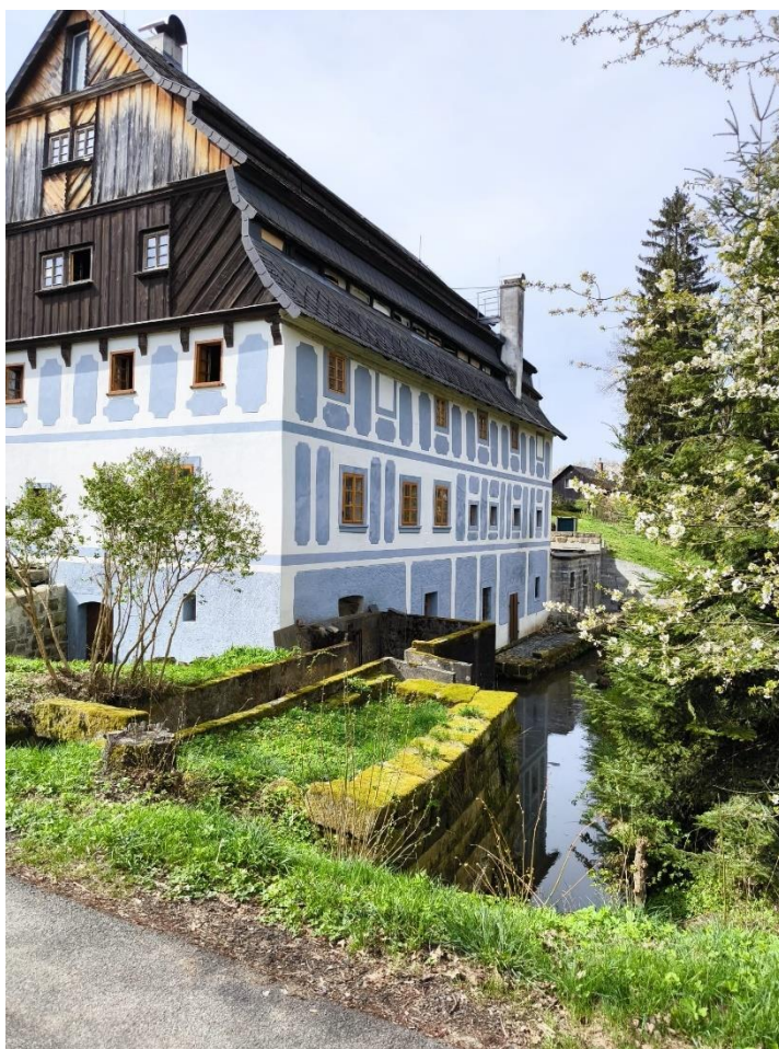
Obrázek 19 Zrekonstruovaná budova bývalé papírny v Hamru na Jezeře, v popředí jsou dochované náhony z nedalekého rybníka, v roce 2017 zvolena jako Památka roku Libereckého kraje, Zdroj: vlastní foto, 2024
