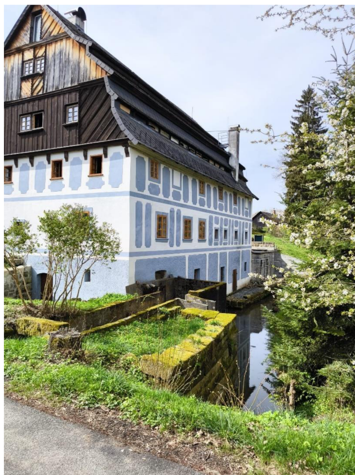
Obrázek 19 Zrekonstruovaná budova bývalé papírny v Hamru na Jezeře, v popředí jsou dochované náhony z nedalekého rybníka, v roce 2017 zvolena jako Památka roku Libereckého kraje, Zdroj: vlastní foto, 2024
