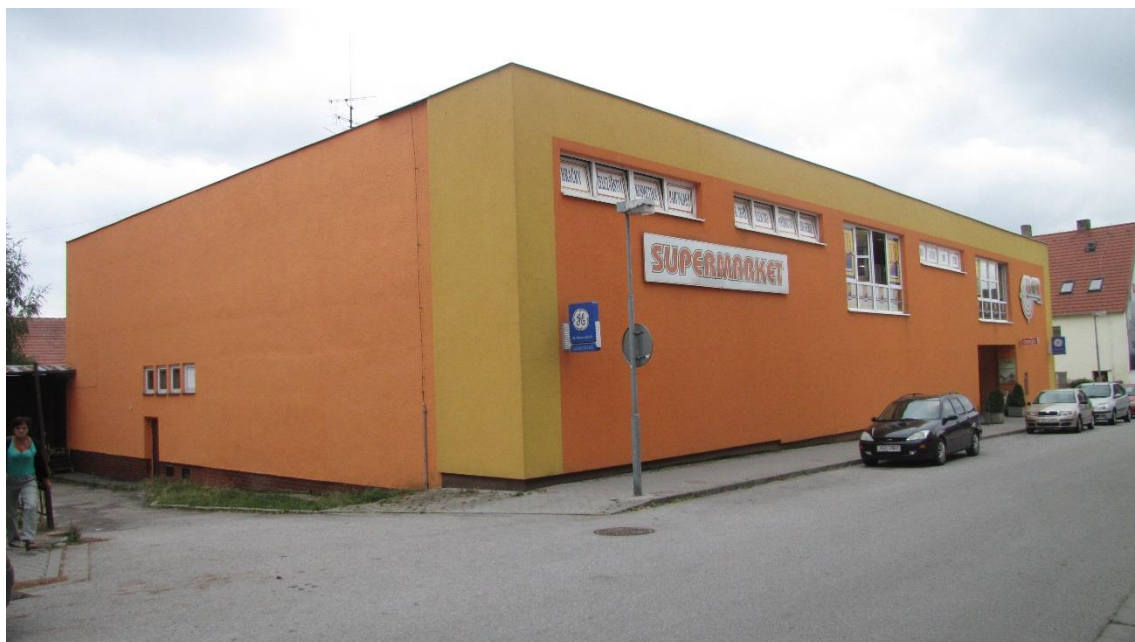
Obrázek 10 - Objekt nákupního střediska
