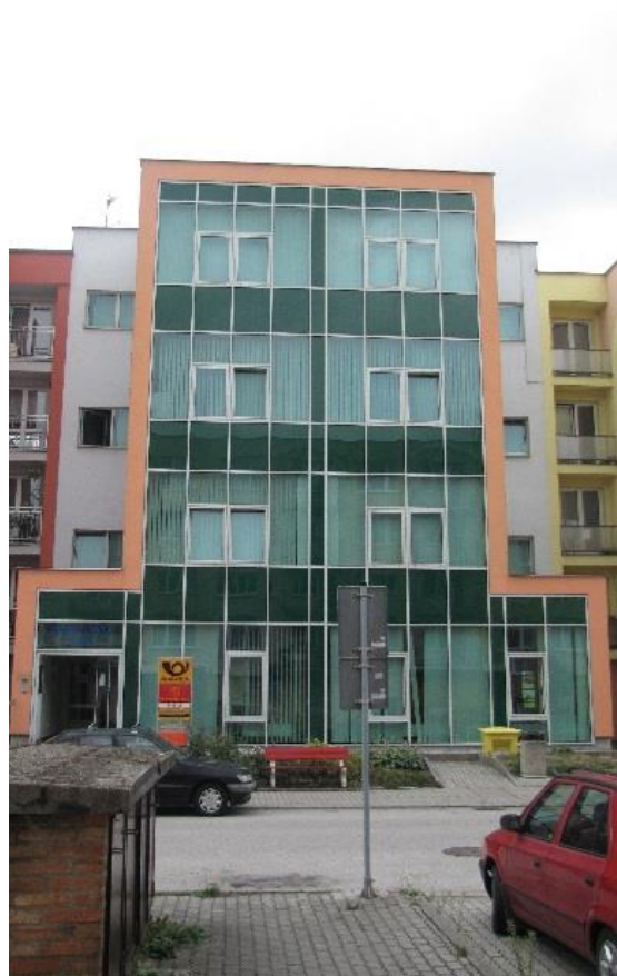
Obrázek 19 - objekt multifunkčního domu
