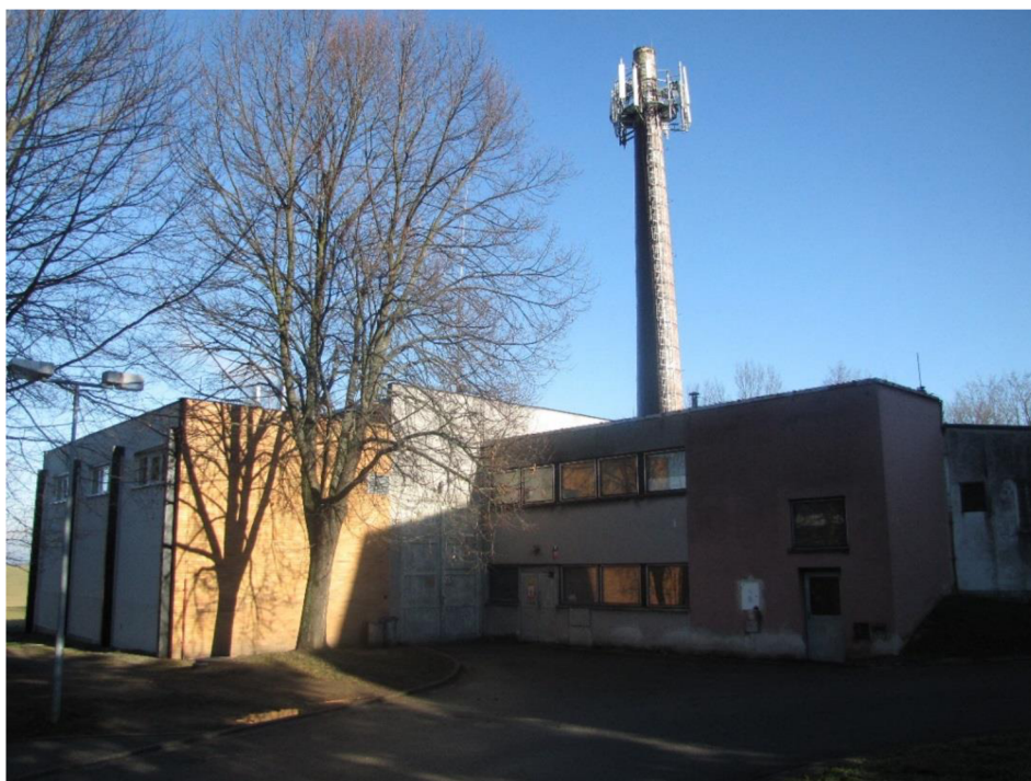
Obrázek 9 - Objekt kotelny - jihozápadní pohled
