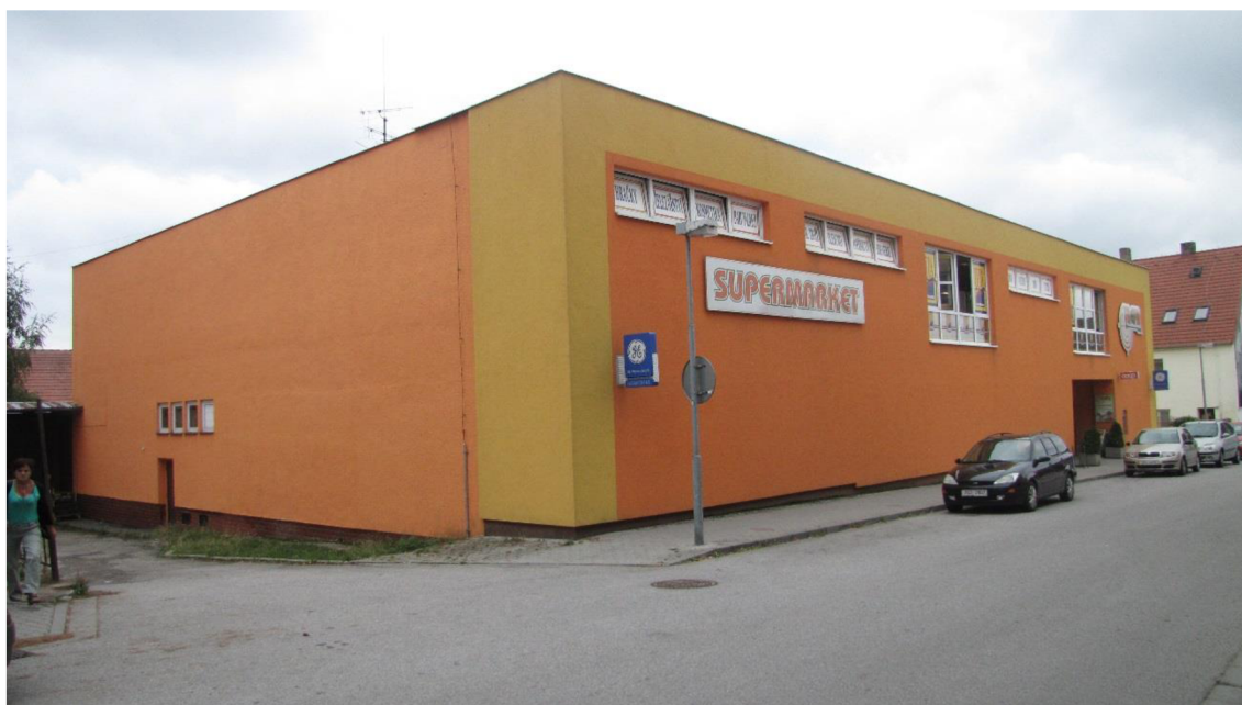
Obrázek 10 - Objekt nákupního střediska
