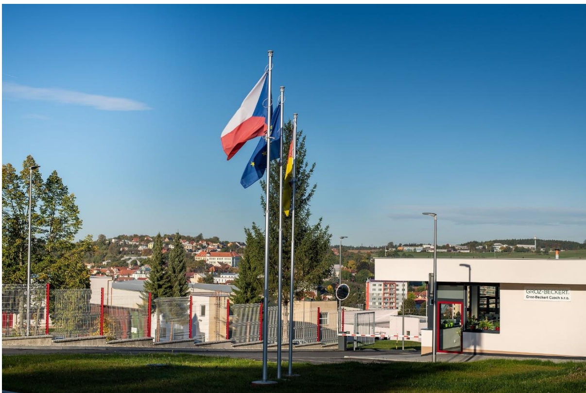
Obr. 1: Výrobní závod ve Valašských Kloboukách [interní foto firmy]
