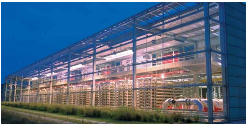
Obr. 4.1 Provozní budova s nanofiltračními moduly [19]
