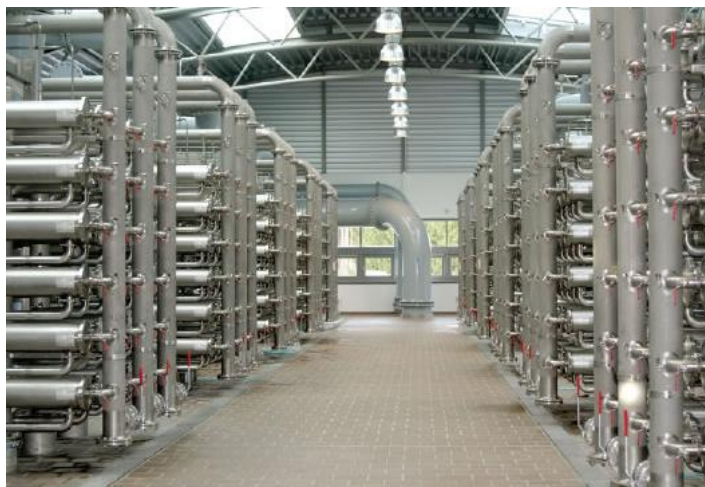
Obr. 4.6 Bloky tlakových trub nanofiltrace [24]
