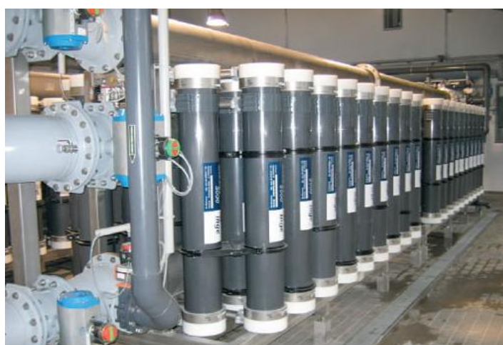
Obr. 4.7 Ultrafiltrační zařízení pro čištění prací vody [24]
