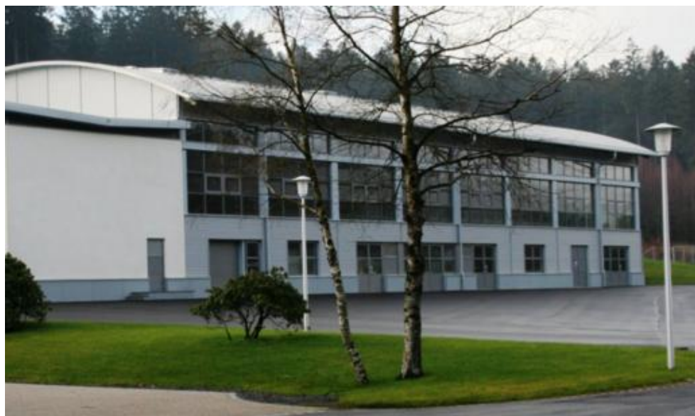
Obr. 4.4 Budova úpravny vody v Roetgenu [22]
