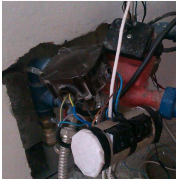
Obr. 4.5: Čerpadlo s přepínacím obvodem
