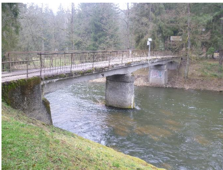
Obrázek 16: Most vodní elektrárna Sedlice (autor)
