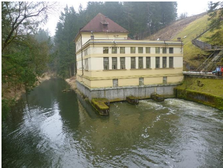
Obrázek 19: Vodní elektrárna Sedlice (autor)
