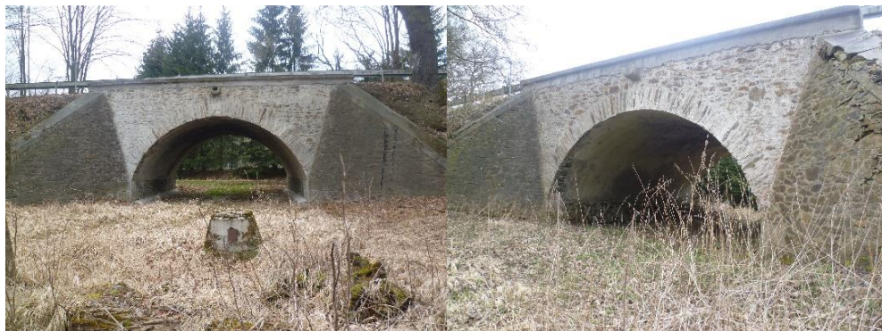
Obrázek 13: Inundační pole Křelovice – Želiv (autor)
