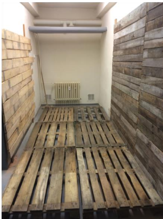
Obrázek 10: Tajná místnost během obkládání dřevem (zdroj: autor práce)
