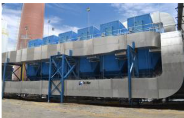
Obr. 4.3 Baterie svíčkových katalytických filtrů UltraCat [42]
