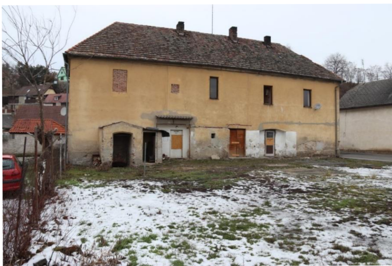
Fotografie 1 - Budova „Staré školy“
