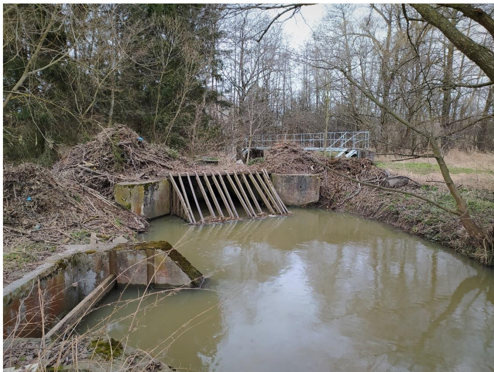
Obrázek 23: Hrubé česle před zaústěním náhonu Úslavy pod vodní tok Bradavy (Tesař V., 2023)
