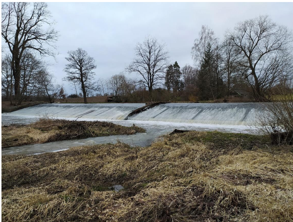
Obrázek 31: Pohled na jez Štáhlavy I (Tesař V., 2023)
