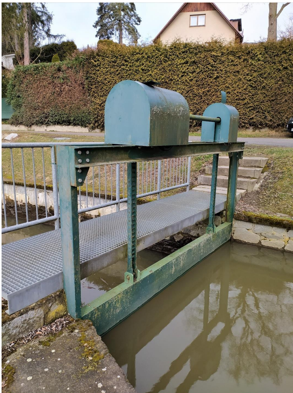
Obrázek 39: Stavidlo na náhonu na jezu Sedlec (Tesař V., 2023)
