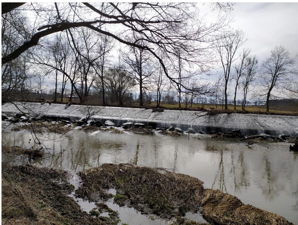
Obrázek 33: Pohled na jez Štáhlavy II (Tesař V., 2023)
