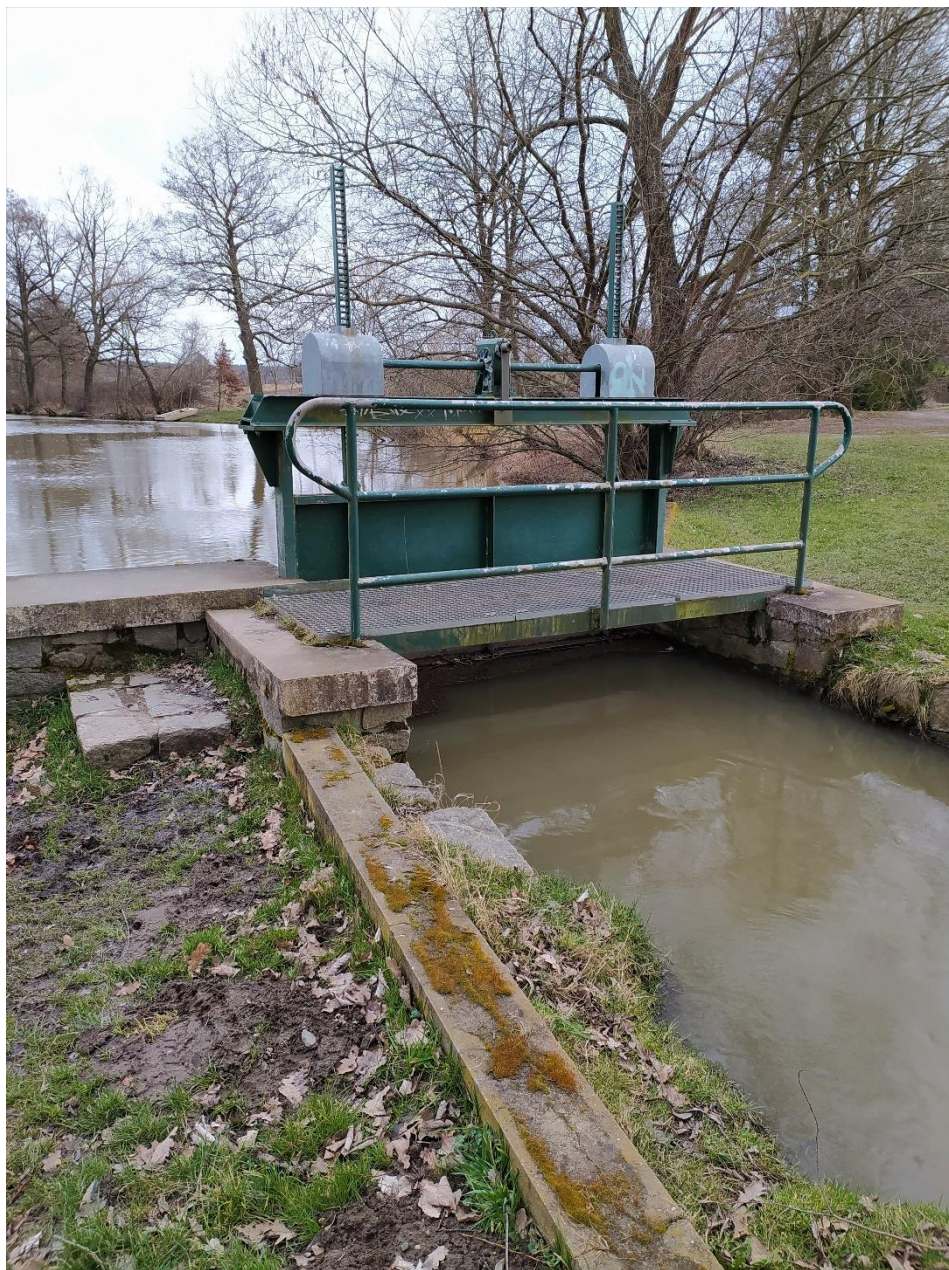
Obrázek 37: Stavidlo na náhonu ze vzdutí jezu Šťáhlavy I (Tesař V., 2023)
