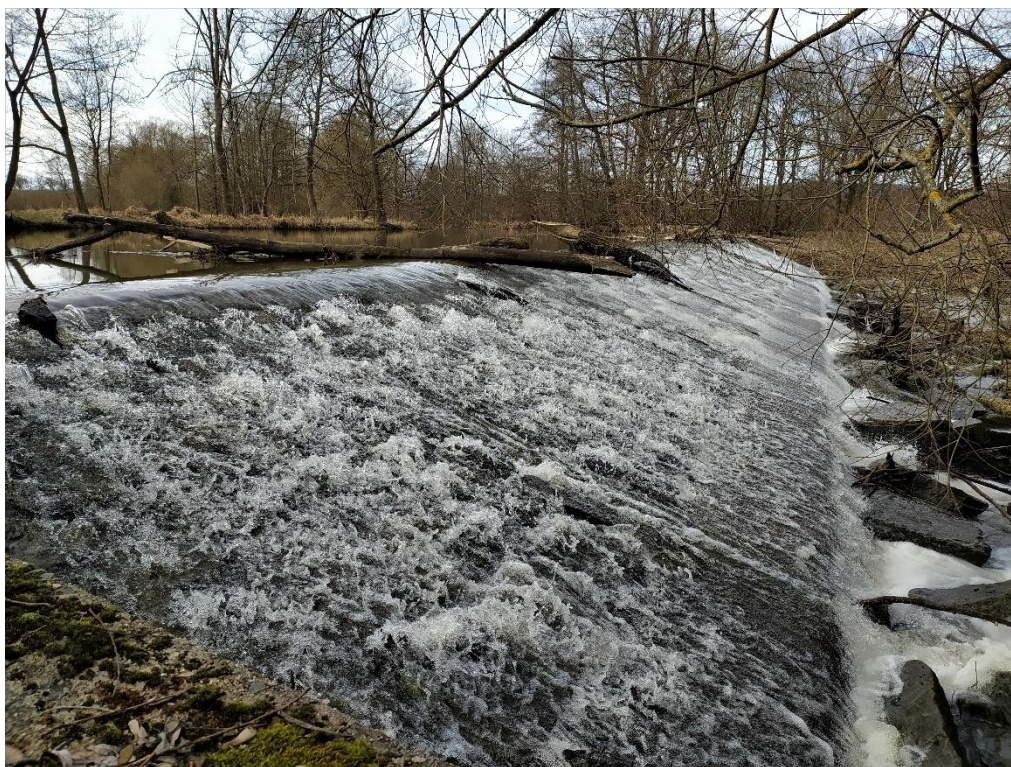
Obrázek 34: Detailní pohled na jez Štáhlavy II (Tesař V., 2023)
