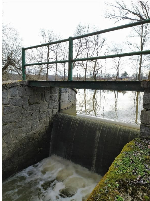
Obrázek 12: Jezová propust na jezu Šťáhlavy II (Tesař V., 2023)
