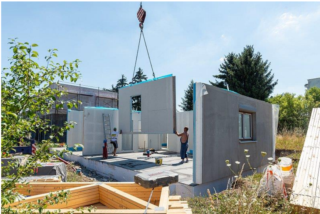
Obrázek č. 4 probíhající montáž panelové dřevostavby za pomoci jeřábu (Němcová, 2019).
