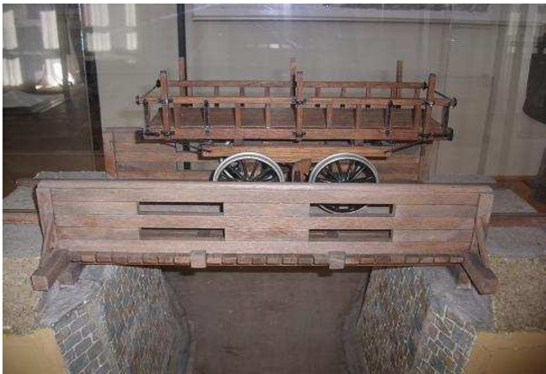
Obr. č. 6. a č. 7. Model železničního náspu na koněspřežce s nasucho zděnou kamennou zdí a mostem.
