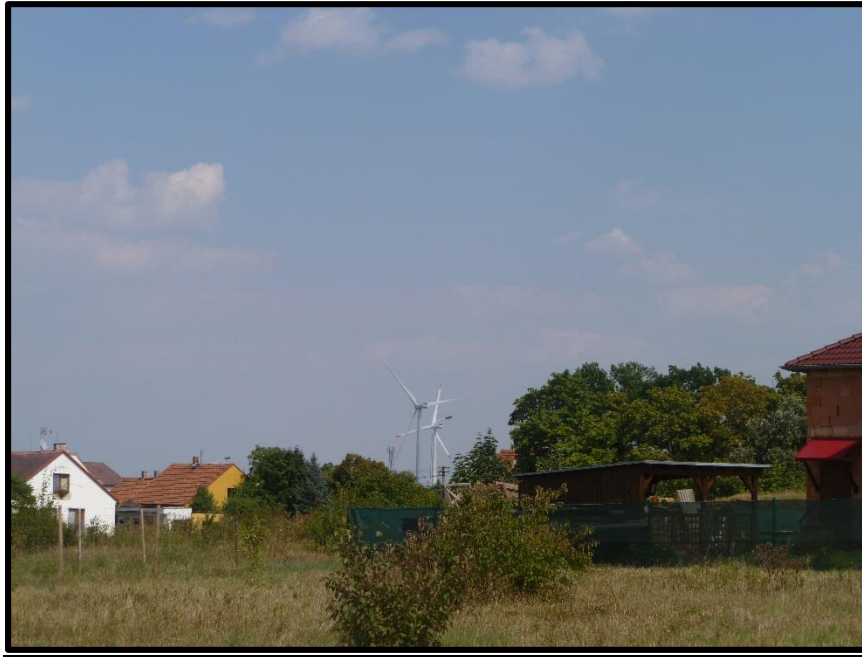
Pohled na elektrárny: Pchery - Humny
