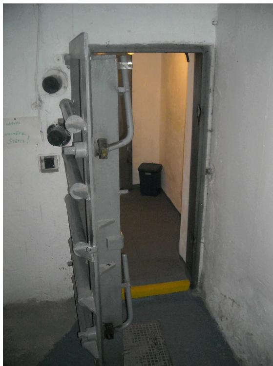
Obrázek 1, vchod do STOÚ – tlakově odolné dveře
