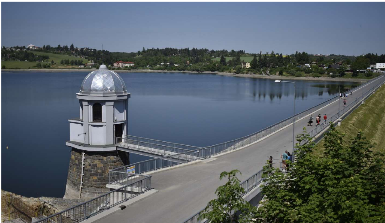
Obr. č. 2 Pohled na věžový výpustný objekt a korunu hráze [6]
