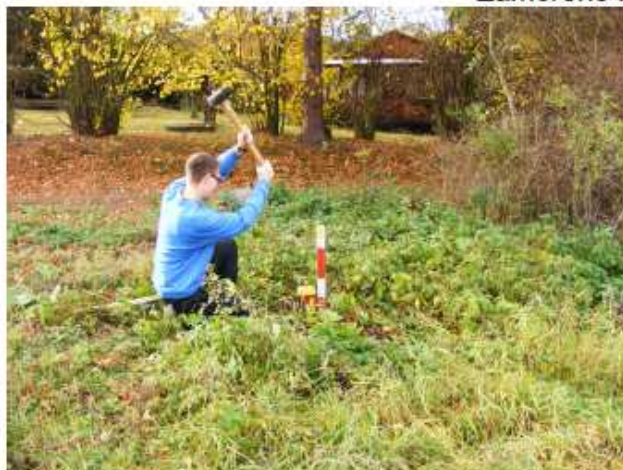
Stabilizace lomového bodu plastovým mezníkem.
