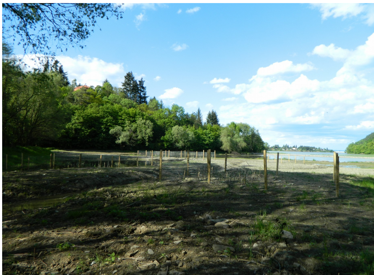
Obrázek 3: Nově vybudovaný mokřad u konce vzdutí VN Plumlov, srpen 2015 (orig. Kateřina Frélichová)
