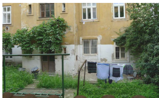
Obr. č. 68: fotografie C vnitrobloku č. 5.
