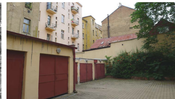
Obr. č. 76: fotografie A vnitrobloku č. 6.
