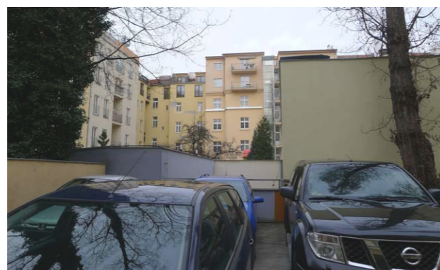
Obr. č. 58: fotografie C vnitrobloku č. 4.
