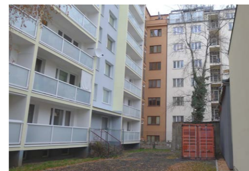
Obr. č. 110: fotografie C vnitrobloku č. 9.
