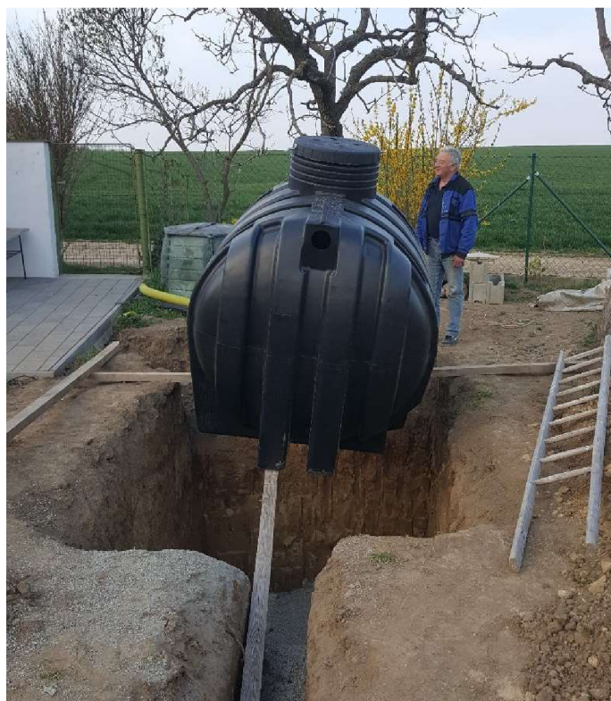
Obr. 4 Ukázka instalace nádrže na dešťovou vodu na pozemku rodinného domu na jižní Moravě [25]
