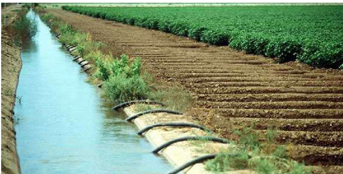
Obr. 15 Odběr vody pro závlahu [19]
