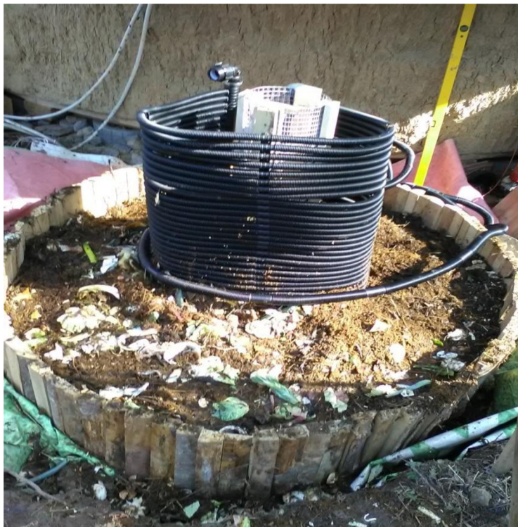
Obrázek 4-6 Umístění výměníku do bioreaktoru
