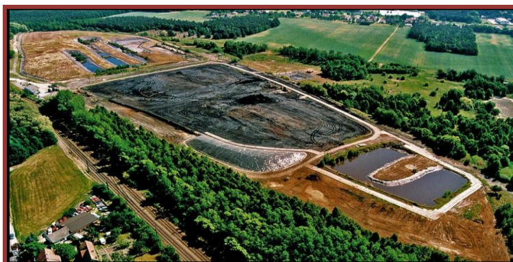
Obrázek 27: Dehtová deponie – před sanací, r. 1999, zdroj: LMBV
