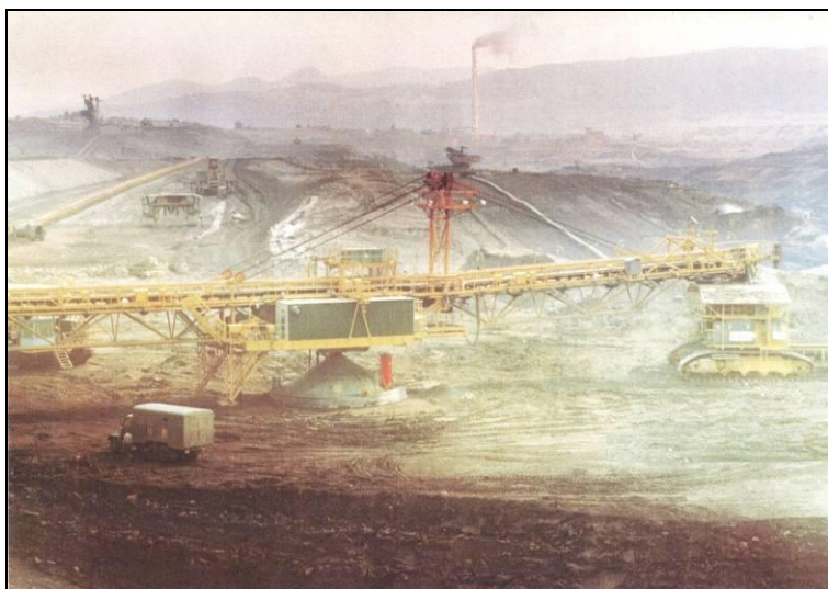
Obrázek 7: Pohled ze západního křídla na lom Chabařovice, směr východ, r. 1994, zdroj: PKÚ
