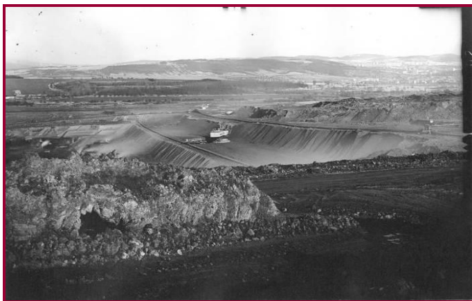
Obrázek 9: Pohled z jihu na východ (r. 1990)
