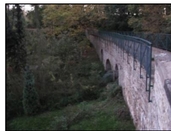
Obrázek 106: Akvadukt vojtěšského vodovodu (zdroj: vlastní).
