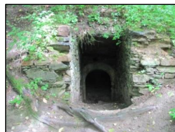
Obrázek 301: Podzemní prostory u mlýna Cimburk (zdroj: vlastní).
