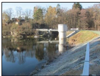
Obrázek 320: Opravená hráz Velkého rybníka (zdroj: vlastní).
