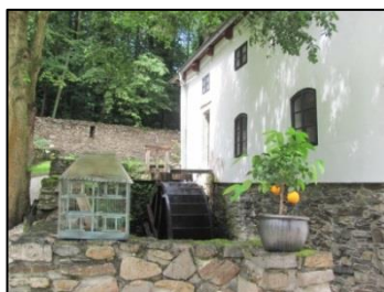
Obrázek 130: Jižní strana mlýna Denmark s mlýnským kolem (zdroj: vlastní).
