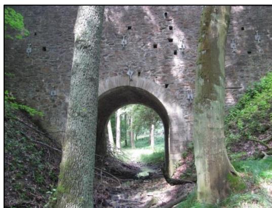
Obrázek 249: Kamenný oblouk mostu v oboře Švadlenka (zdroj: vlastní).
