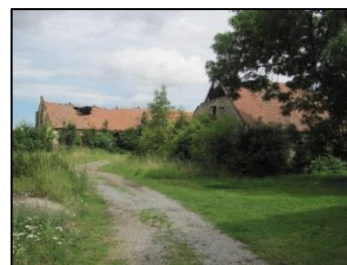
Obrázek 207: Areál stavení č. p. 2 (zdroj: vlastní).
