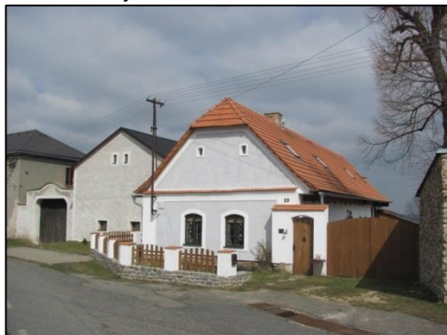
Obrázek 72: Obytné stavení zem. usedlosti č. p. 23 a branou a brankou (zdroj: vlastní).
