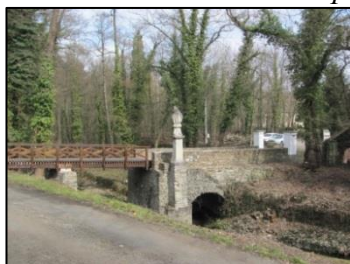
Obrázek 149: Most přes Vrchlici (zdroj: vlastní).
