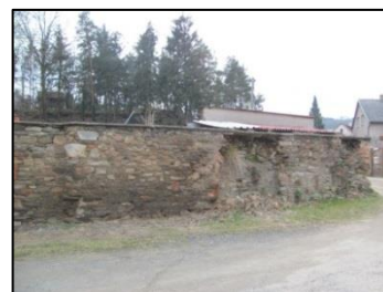
Obrázek 96: Kamenná zeď u budovy radnice (zdroj: vlastní).
