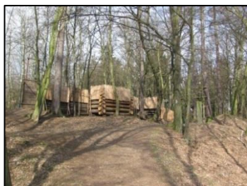
Obrázek 77: Nové dřevěné opevnění před zříceninou hradu Sion (zdroj: vlastní).
