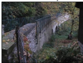
Obrázek 104: Akvadukt vojtěšského vodovodu (zdroj: vlastní).
