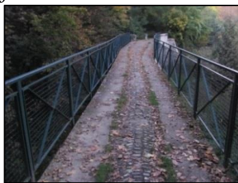
Obrázek 105: Akvadukt vojtěšského vodovodu (zdroj: vlastní).
