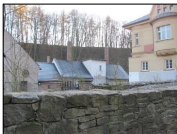
Obrázek 304: Doplnkové budovy u Spáleného mlýna (zdroj: vlastní).
