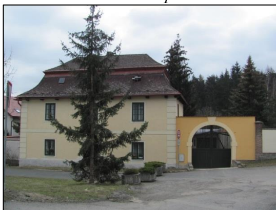
Obrázek 126: Usedlost č. p. 64/Ž (zdroj: vlastní).
