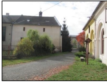
Obrázek 166: Bývalá hospodářská budova, dnes č. p. 71 (zdroj: vlastní).
