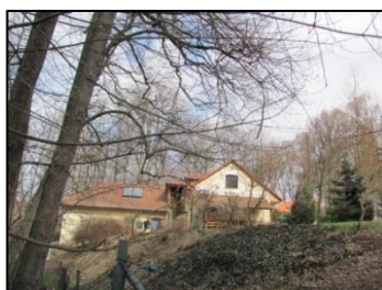
Obrázek 245: Budova bývalé hájovny (zdroj: vlastní).
