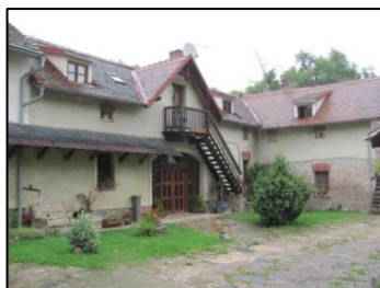
Obrázek 273: Pohled ze dvora na bývalé hospodářské budovy usedlosti č. p. 17 (zdroj: vlastní).
