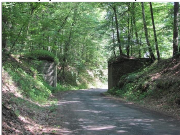
Obrázek 344: Mostní pilíře v oboře Švadlenka(zdroj: vlastní).
