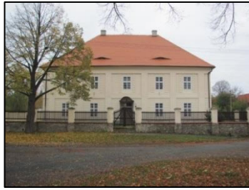
Obrázek 165: Budova malešovského zámku (zdroj: vlastní).
