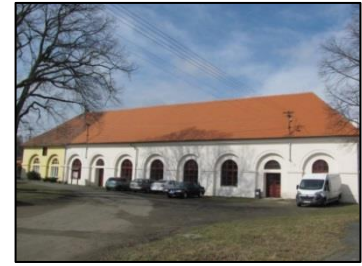
Obrázek 167: Východní hospodářská budova (zdroj: vlastní).
