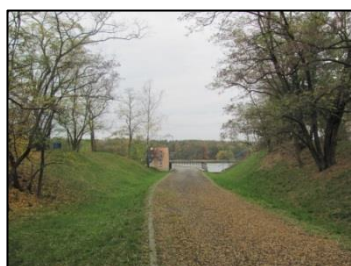
Obrázek 10: Hráz vodní nádrže Vrchlice (zdroj: vlastní).
