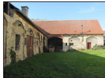
Obrázek 225: Hospodářské budovy u zájezdního hostince č. p. 20 (zdroj: vlastní).
