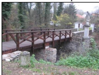
Obrázek 150: Most přes Vrchlici (zdroj: vlastní).
