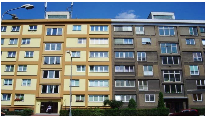
Obr. 5: Provedená revitalizace – DECPLAST, Brno
