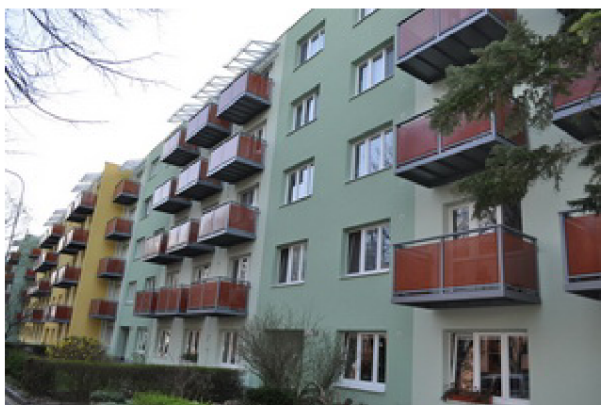
Obr. 4: Provedená revitalizace – PROFIPLAST, Kotěrova, Brno
