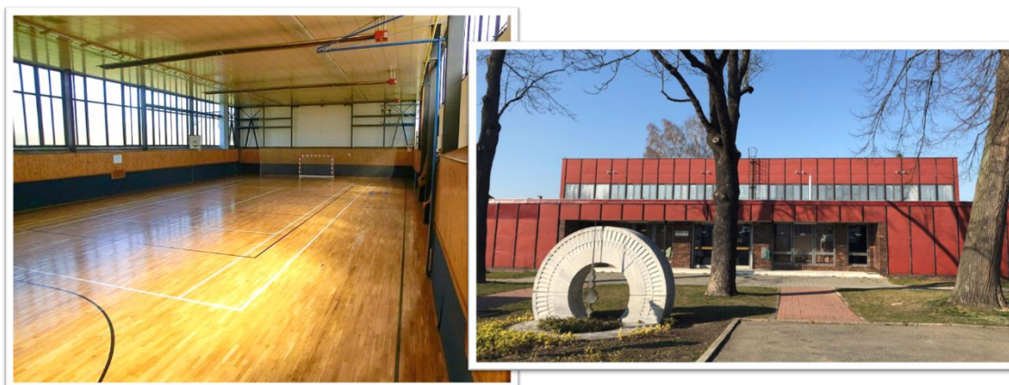
Obrázek 43. Vlevo interiér sportovní haly s podlahou opravenou po povodni 2006, vpravo celkový pohled na sportovní halu. Archiv TJ Lokomotiva Veselí nad Lužnicí.
