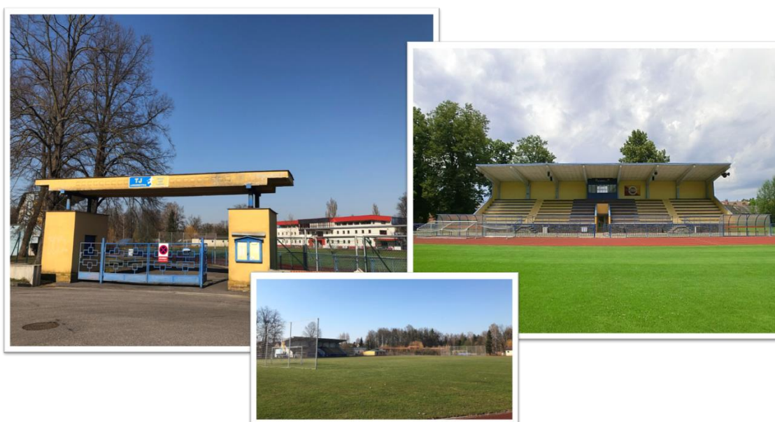
Obrázek 39. Fotbalový stadion ve Veselí nad Lužnicí – vlevo brána na fotbalový stadion, vpravo tribuna, dole celkový pohled. Vlastní zdroj.
