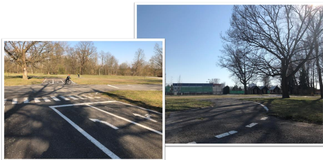
Obrázek 16. Dětské dopravní hřiště ve Veselí nad Lužnicí s asfaltovými cestami, které slouží po opravách až dodnes k dopravní výuce mládeže. Vlastní zdroj.
