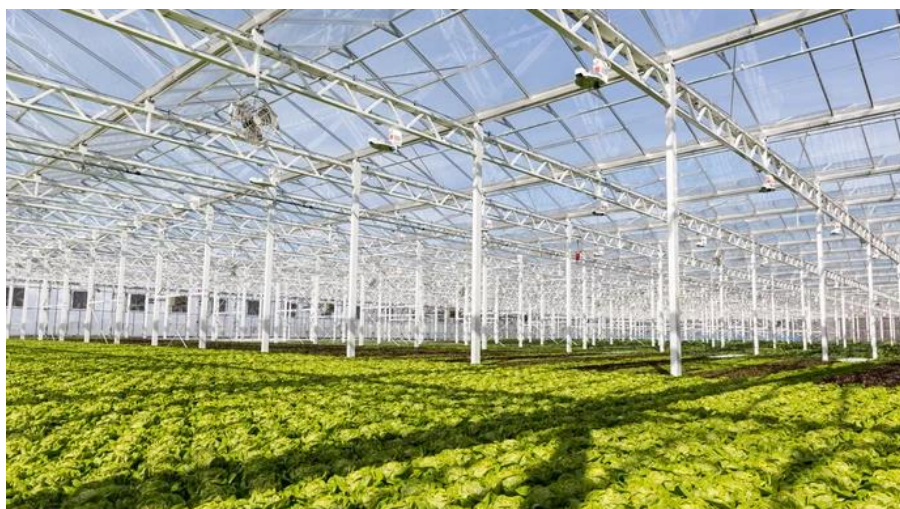
Obrázek 13 – Klimatizovaný střešní skleník [20]
