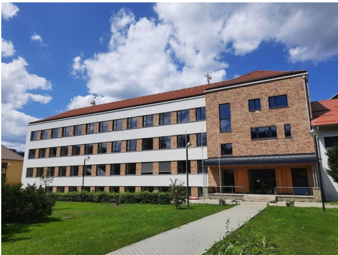
Budova základní školy v Novém Hrozenkově 52
