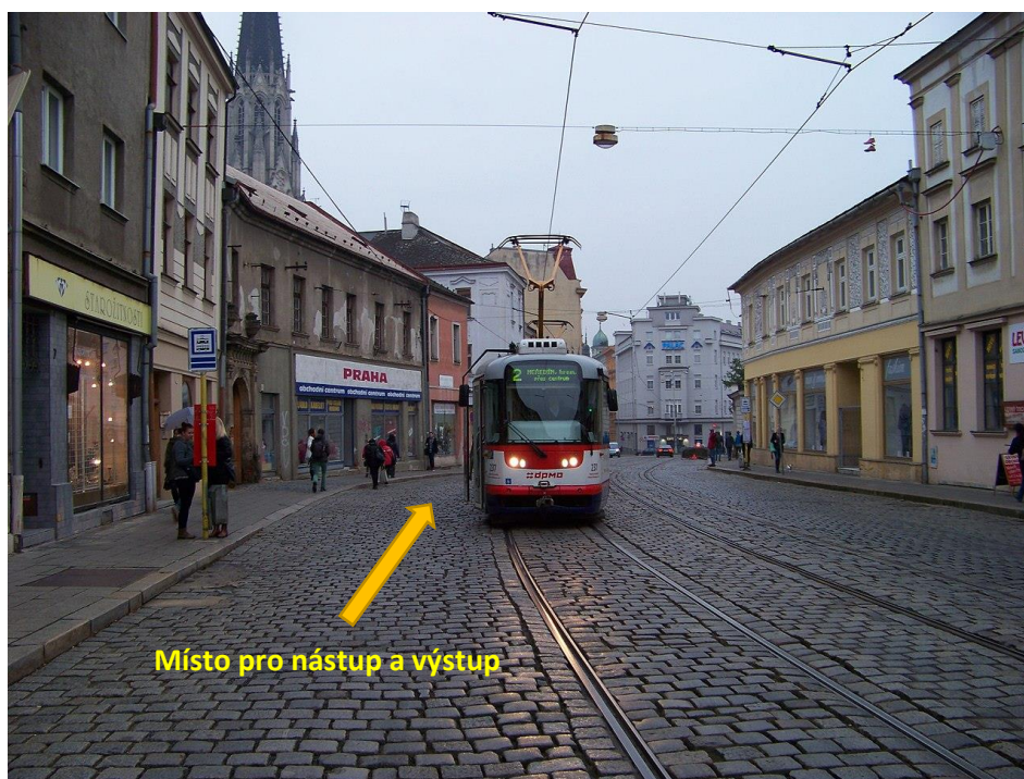
Obr. 24: Zastávka U Dómu v roce 2014 ještě jako zastávka bez zvýšeného nástupiště s nástupem z vozovky. Zdroj: ŠJů, Wikimedia Commons, 2014, CC BY 4.0.
