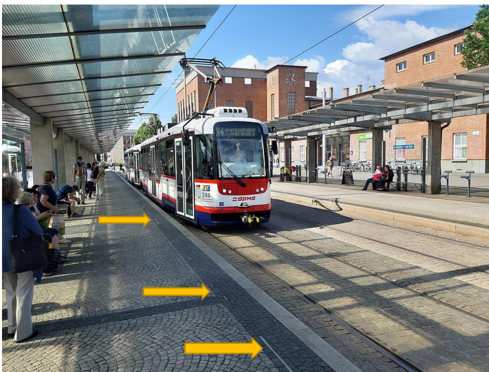
Obr. 19. Pruhy světelné výstražné zařízení (patrné na okraji nástupiště; vyznačeno šipkami). Zastávka Hlavní nádraží.
