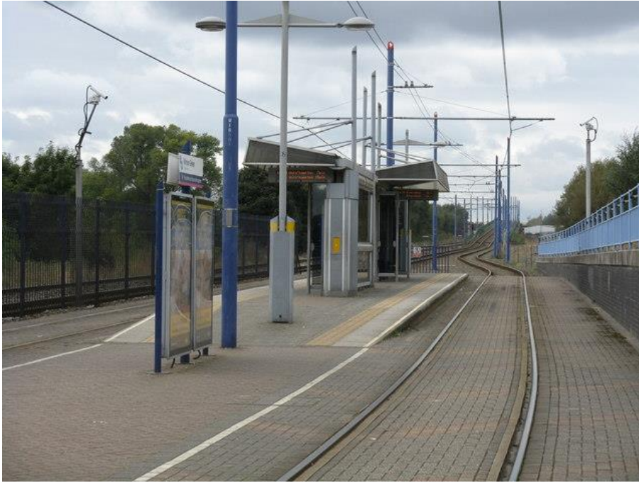
Obr. 10: Zastávka s ostrovním nástupištěm. Zastávka Winson Green, Outer Circle v Birminghamu. Zdroj: Peter Whatley, 2008, CC BY-SA 2.0.
