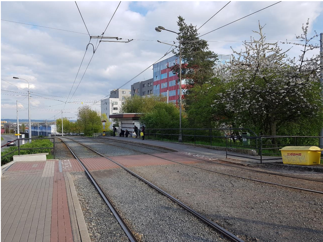
Obr. 7: Zastávka se samostatným nástupištěm. Zastávka Nová Ulice. Zdroj: Vlastní fotografie, 2022
