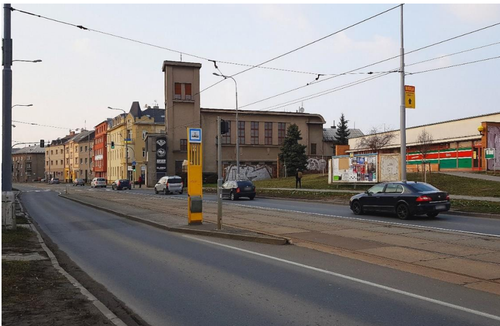
Obr. 23: Zastávka Husův sbor. Absence stejných bezpečnostních prvků jako u zastávky Bělidla.
