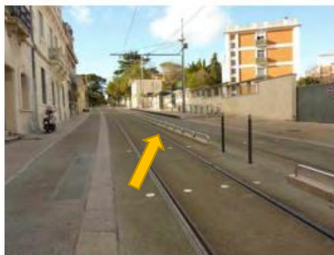
Obr. 18: Bariéra mezi kolejemi na tramvajové zastávce v Lyonu (vyznačena šipkou). Předchází se tím objíždění tramvaje stojící v zastávce motorovými vozidly. Zdroj: COST, 2015
