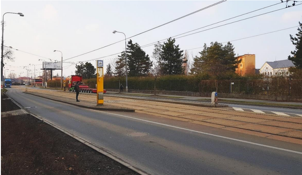
Obr. 22: Zastávka Bělidla. Relativně úzké nástupní ostrůvky bez ochranného zábradlí, přechodu pro chodce a bezbariérového přístupu.
