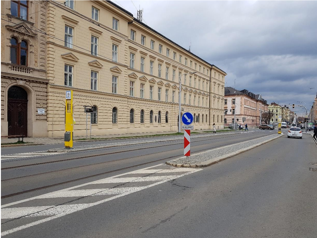
Obr. 14: Zastávka Žižkovo náměstí. Příklad zastávky s úzkými nástupními ostrůvky, bez bezbariérového přístupu a dostatečných bezpečnostních prvků.
