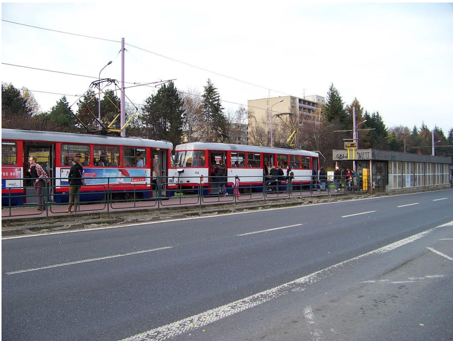
Obr. 11: Zastávka s nástupními ostrůvky a mimoúrovňovým přístupem. Zastávka Fakultní nemocnice. Zdroj: ŠJŮ, Wikimedia Commons, 2014, CC BY 4.0.
