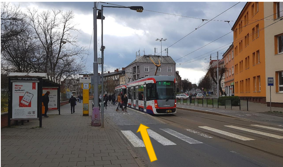
Obr. 8: Zastávka se zvýšeným jízdním pásem – s pojížděným zastávkovým mysem (vyznačen šipkou). Zastávka Výstaviště Flora. Zdroj: Vlastní fotografie, 2022
