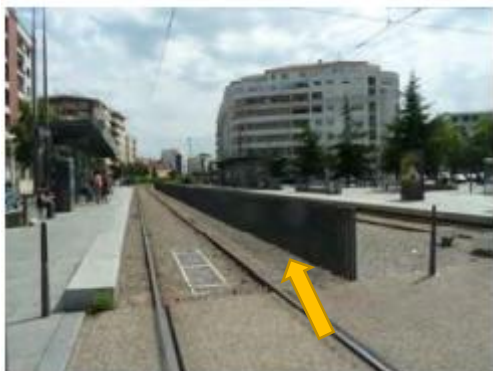
Obr. 17: Bariéra mezi kolejemi na tramvajové zastávce (vyznačena šipkou). Předchází se tak přecházení chodců přes kolejiště mimo vyhrazený prostor. Zdroj: COST, 2015.
