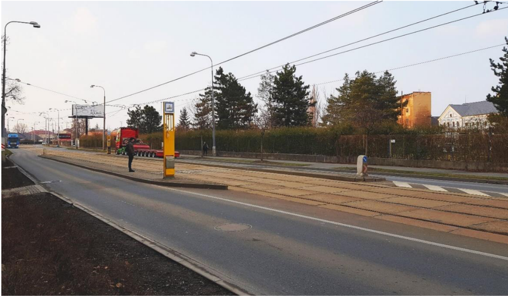
Obr. 22: Zastávka Bělidla. Relativně úzké nástupní ostrůvky bez ochranného zábradlí, přechodu pro chodce a bezbariérového přístupu.
