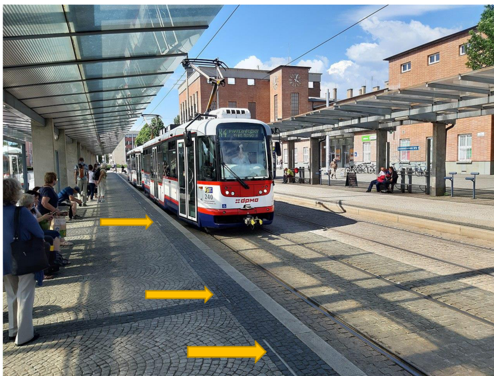
Obr. 19. Pruhy světelné výstražné zařízení (patrné na okraji nástupiště; vyznačeno šipkami). Zastávka Hlavní nádraží.
