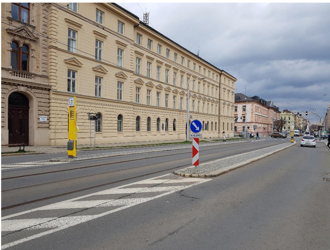
Obr. 14: Zastávka Žižkovo náměstí. Příklad zastávky s úzkými nástupními ostrůvky, bez bezbariérového přístupu a dostatečných bezpečnostních prvků.
