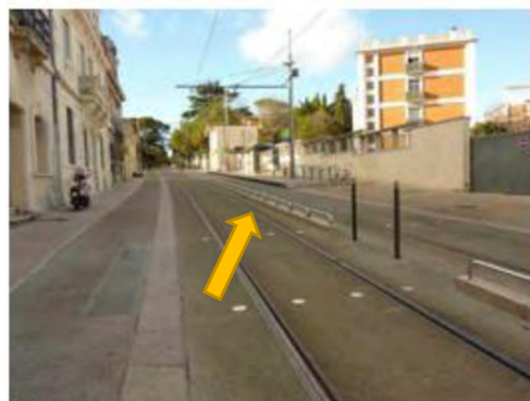
Obr. 18: Bariéra mezi kolejemi na tramvajové zastávce v Lyonu (vyznačena šipkou). Předchází se tím objíždění tramvaje stojící v zastávce motorovými vozidly.
