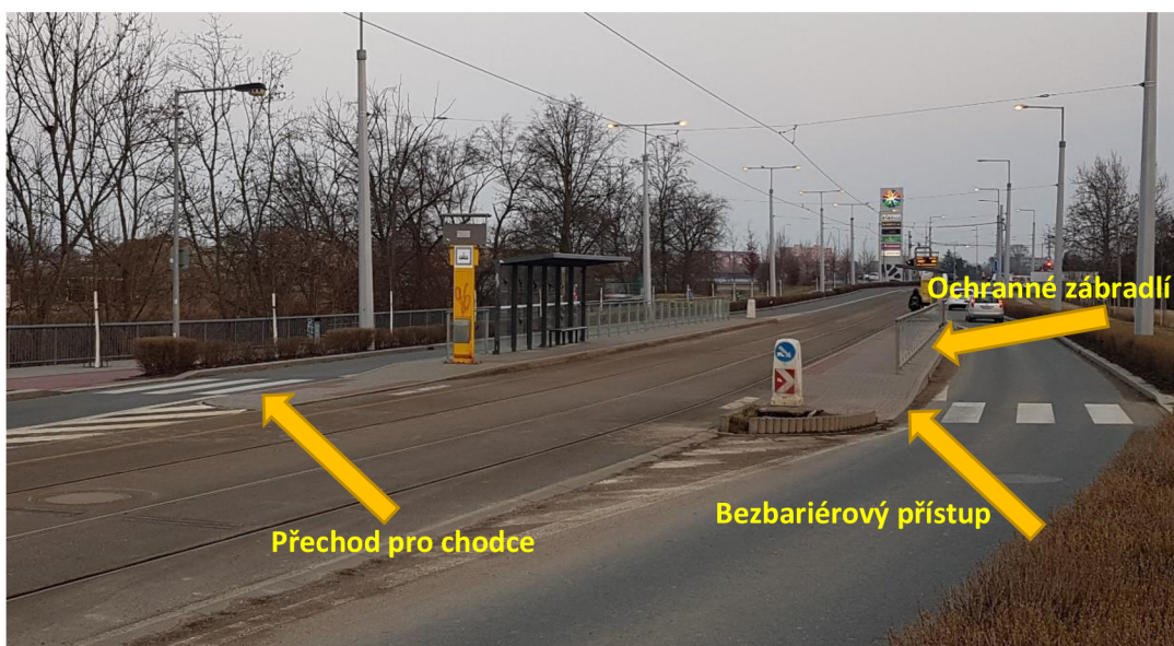
Obr. 13: Zastávka V Kotlině. Příklad zastávky s nástupními ostrůvky vybavené dostatečnými bezpečnostními prvky. Vhodné doplnit bariérou mezi koleje, aby chodci přecházeli kolejiště pouze ve vyhrazeném prostoru.
