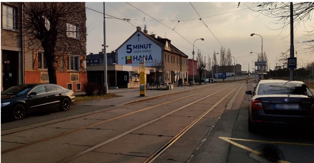
Obr. 6: Zastávka s nástupišti na nepojížděném zastávkovém mysu. Zastávka Autobusové nádraží, podchod. Zdroj: Vlastní fotografie, 2022
