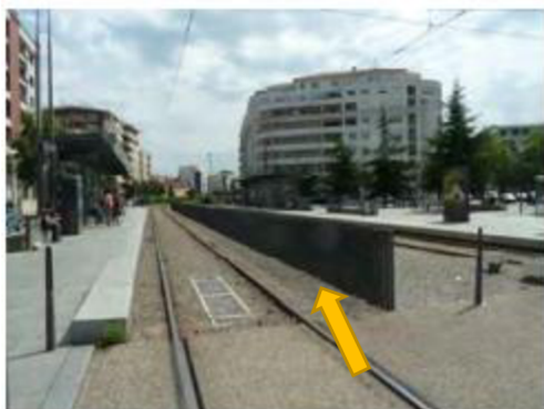
Obr. 17: Bariéra mezi kolejemi na tramvajové zastávce (vyznačena šipkou). Předchází se tak přecházení chodců přes kolejiště mimo vyhrazený prostor.
