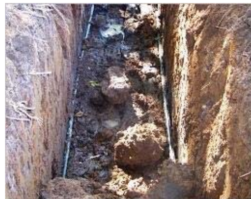
Obr.8 – Zásyp FAST kolektoru vytěženou zeminou bez pískového lože, Zdroj : [15]
