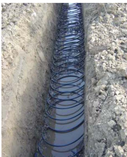
Obr. 5 – Svinování PE hadice ve výkopu, Zdroj: [15]
