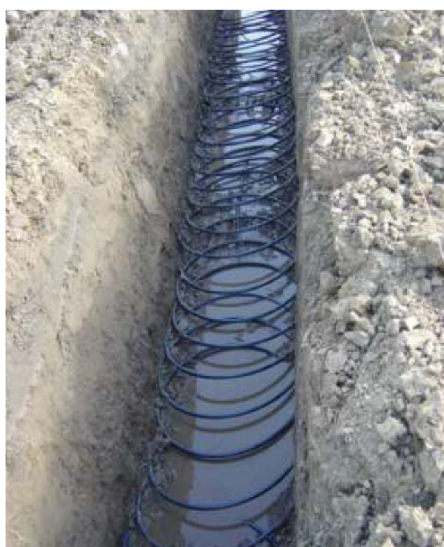
Obr. 5 – Svinování PE hadice ve výkopu, Zdroj: [15]
