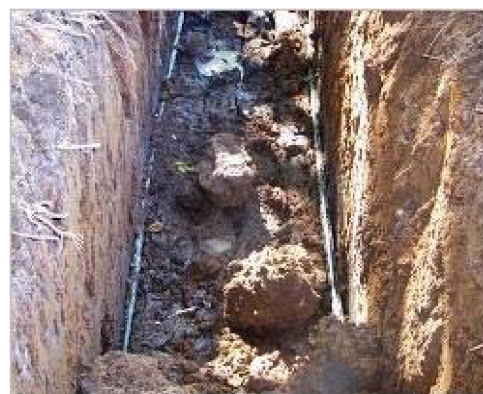
Obr.8 – Zásyp FAST kolektoru vytěženou zeminou bez pískového lože, Zdroj : [15]
