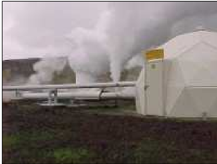
Pohled na Islandskou elektrárnu [23]
