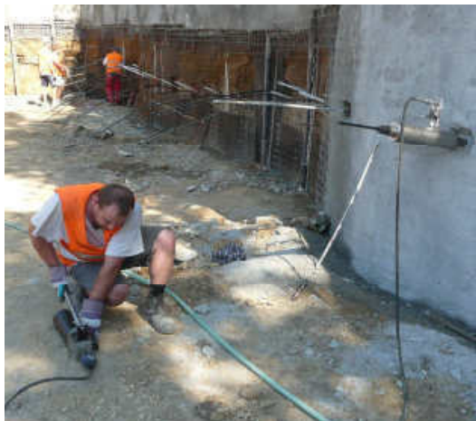
Obr.: 8.3.4 - Pohled na práci napínače zemních kotev
