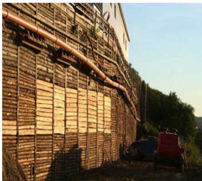
Obr.:2.2.8.2 - Pohled na k-ci záporového pažení
