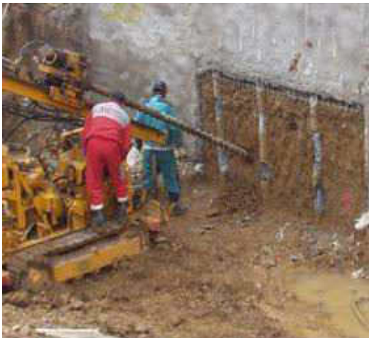
Obr.:2.2.6.2 - Vrtání zemních kotev
