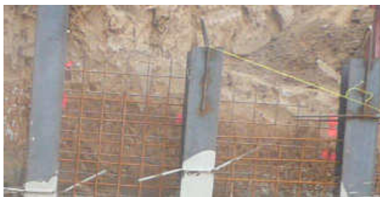
Obr.: 8.2.3 - Pohled na osazené He profily a pomocná oka
