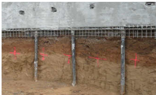
Obr.: 8.3.1 - Pohled na vytyčení zemních kotev
