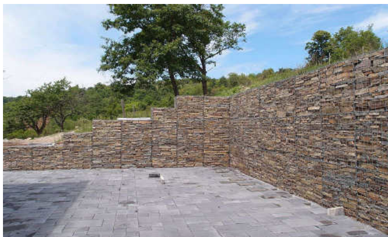
Obr.:3.2.11.2 - Využití gabionu jako opěrná konstrukce
