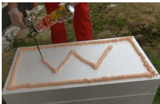
Obr.: 8.4.2 Pohled na vytvořené pruhy na polystyrénu
