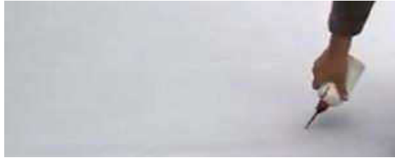
Obr.: 8.3.5 Provádění zalití vytvořených svarů pojistnou zálivkou
