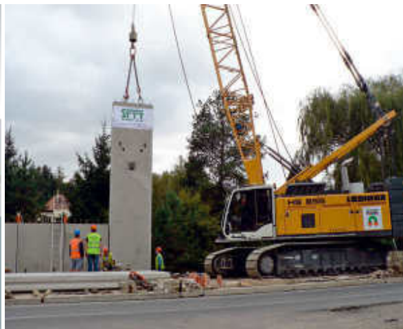
Obr.:2.2.3.2 - Ukládání prefa podzemní stěny
