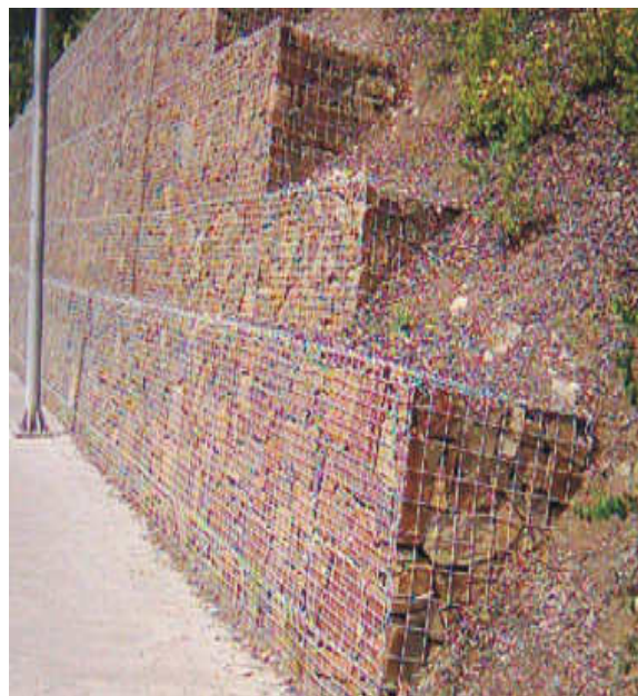
Obr.:2.2.7.2 - Pohled na gabionovou k-ci
