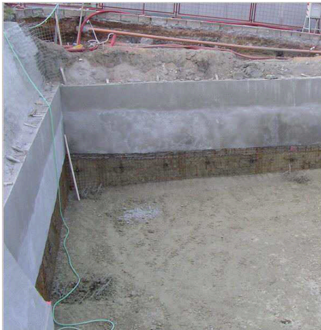
Obr.:2.2.6.3 - Stavební jáma z mikrozápor. pažení
