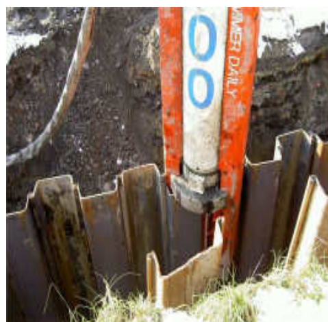
Obr.:2.2.2.2 - Zavibrování štětovnice
