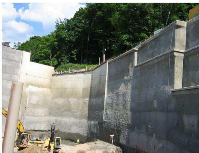
Obr.:3.1.1.1 - Pohled na stěnu vytvořenou pomocí mikrozáporového pažení
