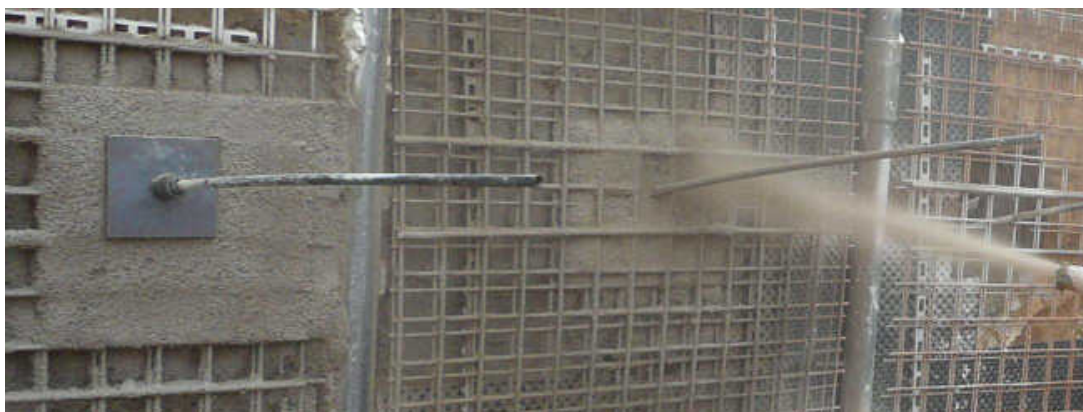
Obr.: 8.4.2 - Pohled na sazení kotevní desky
