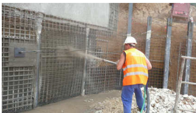
Obr.: 8.5.1 Pohled na pokládku stříkaného betonu
