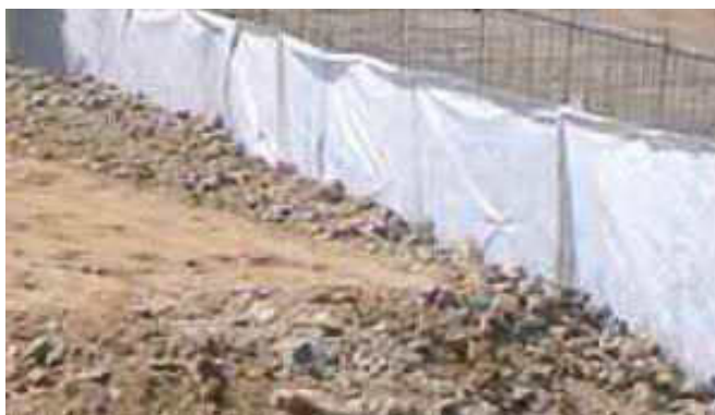
Obr.:3.2.4.6 - Umístění geotextilie
