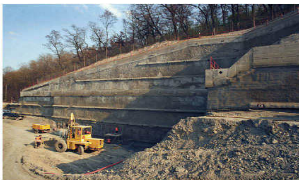
Obr.:2.2.6.1 - Pohled na opěrnou konstrukci z mikrozápor
