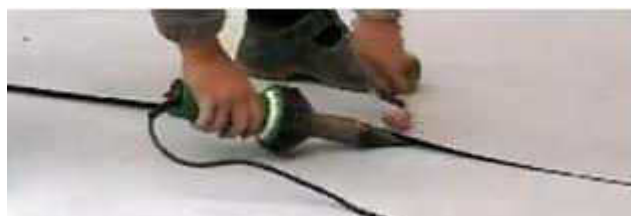
Obr.: 8.3.3 Spojování folií horkým vzduchem
