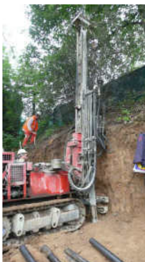
Obr.: 8.2.1 Pohled na vrtnou soupravu při vrtání pilot
