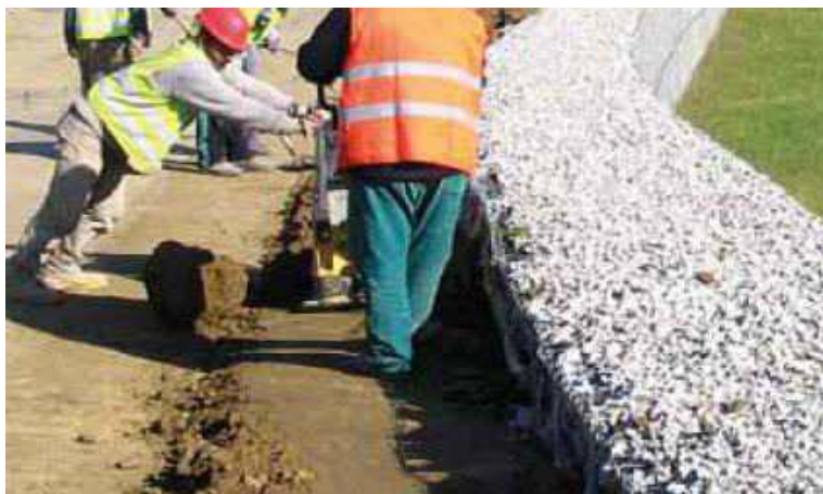
Obr.:3.2.4.12 - Hutnění násypu za konstrukcí
