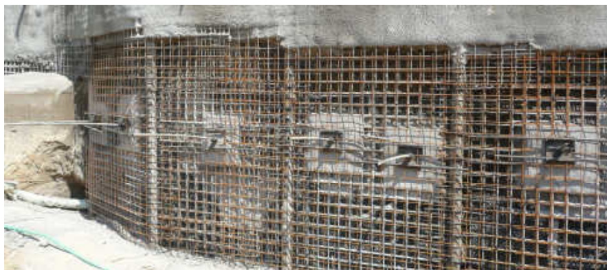
Obr.: 8.4.3 - Pohled na hotovou armaturu opěrné stěny
