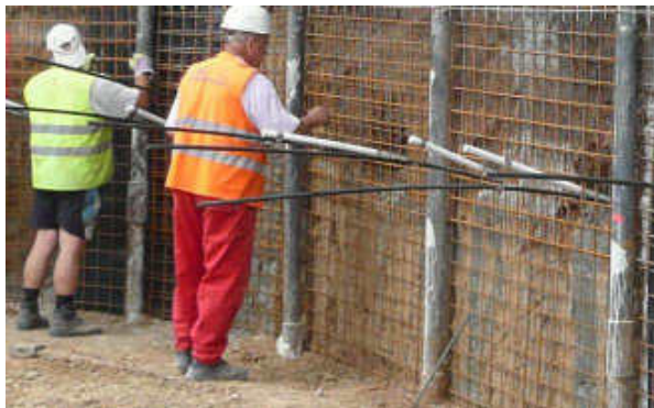
Obr.: 8.4.1 - Osazené 1. řady kari sítě
