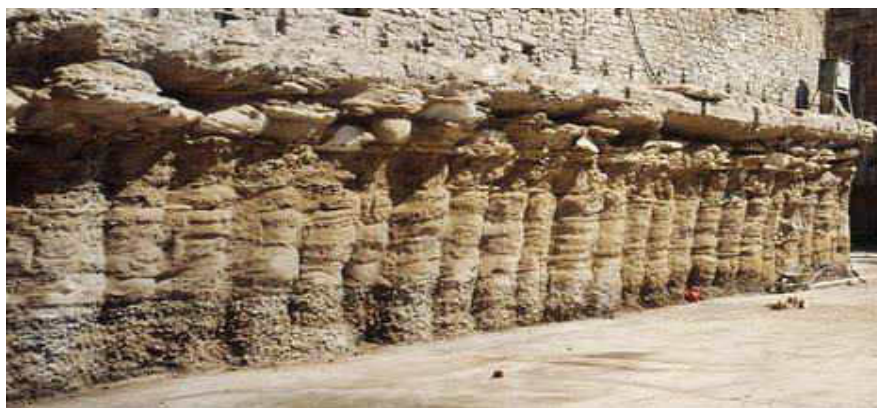
Obr.:2.2.4.2 - Pohled na stěnu tryskové injektáže
