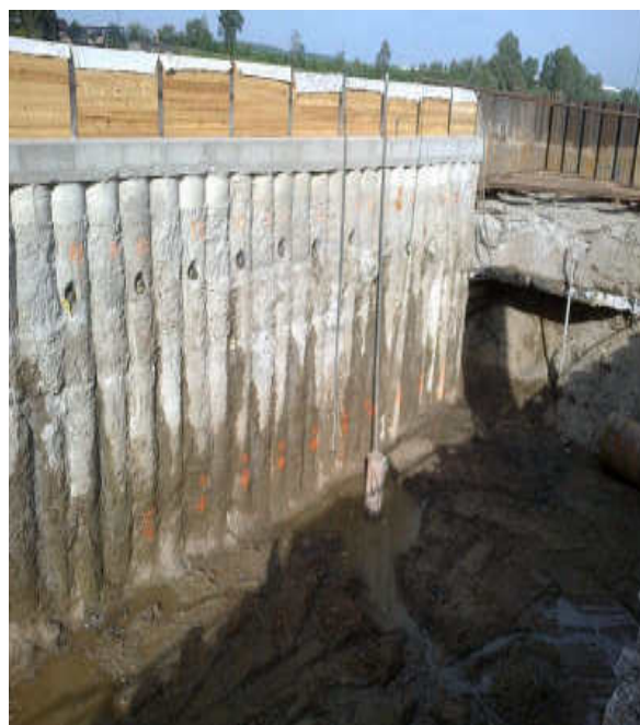
Obr.:2.2.1.5 - Pohled na pilotovou stěnu
