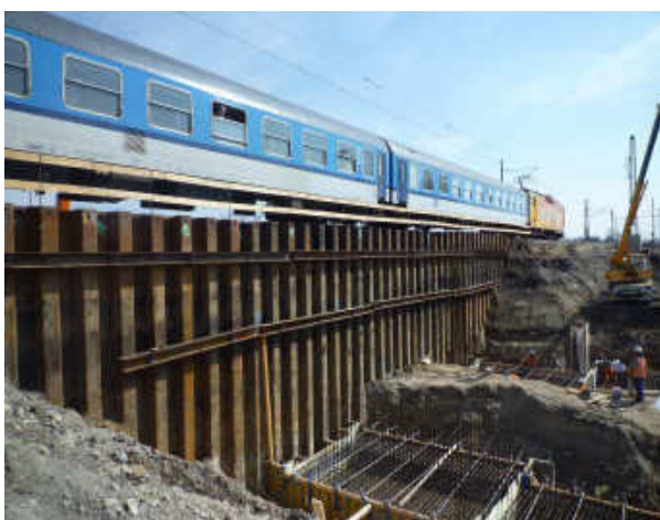
Obr.:2.2.2.1 - Pohled na štětovicovou stěnu
