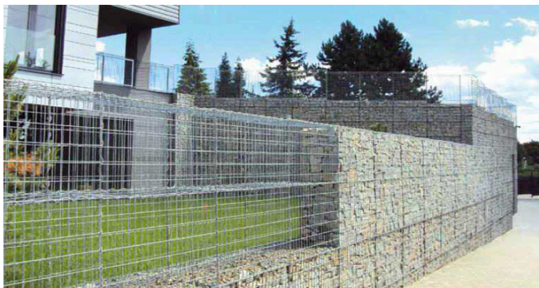
Obr.:3.2.11.1 Využití gabionu jako dělicí konstrukce – oplocení
