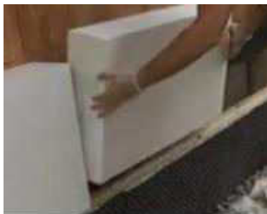
Obr.: 8.4.3 Pohled na správné položení TI desky
