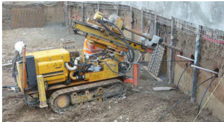
Obr.: 8.3.2 - Pohled na vrtnou soupravu při vrtání zemních kotev
