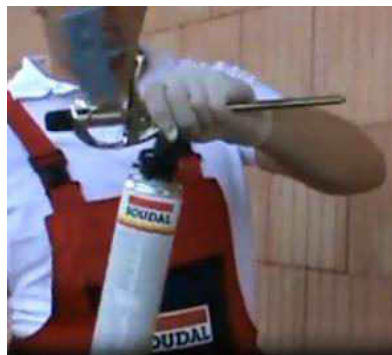
Obr.: 8.4.1 Umístění pistole na dózu
