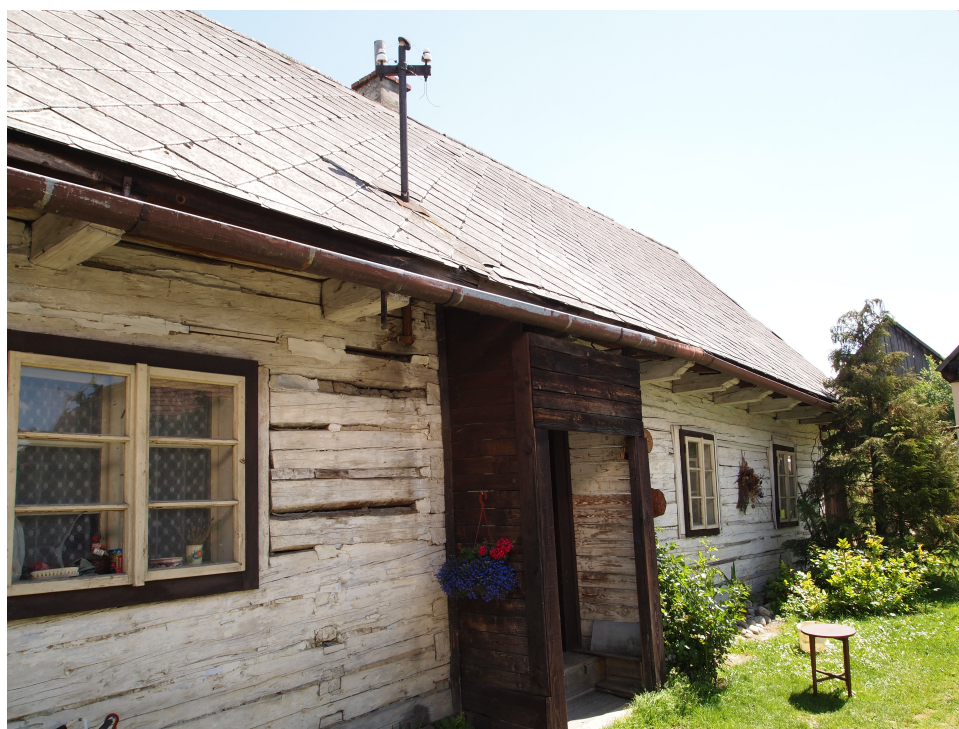
Príloha č. 25: Dom č. 41/b z roku 1823 – pohľad zo západu, stav v roku 2017**
