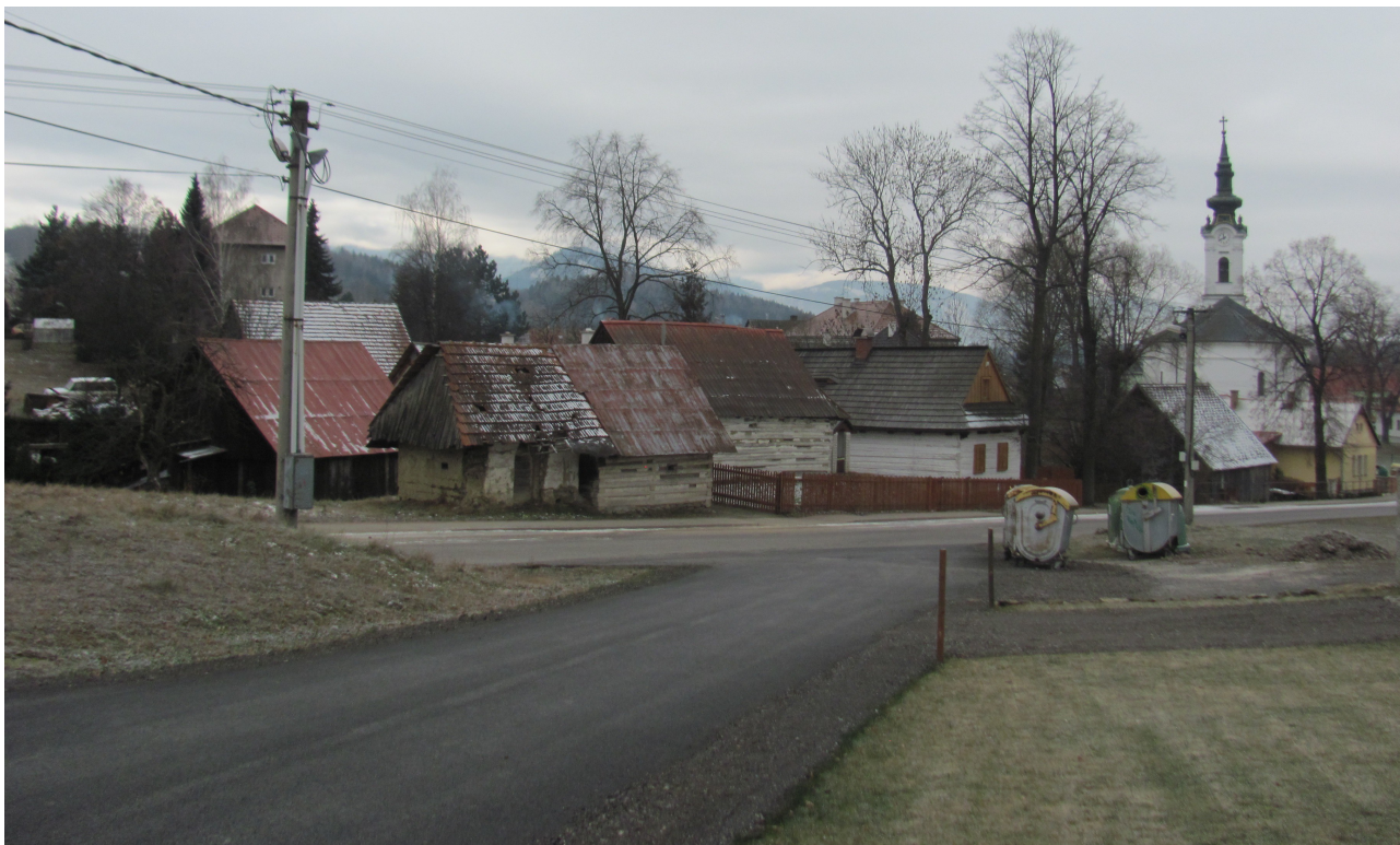
Príloha č. 15: Stará sypáreň (drevená hosp. budova so škridlovou strechou, zač. 40. r. 20. stor. evidovaná ako chliev), maštal' a napravo od nich niekdajšie miesta domov č. 16, 17 (opravená drevenica) a 18 (žltý dom vpravo), v pozadí evanjelický kostol, stav v roku 2018*
