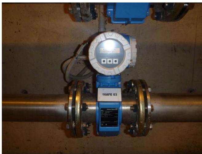
Obrázek 8: Měření průtoku primárního kalu (Zdroj Autor, 2017)
