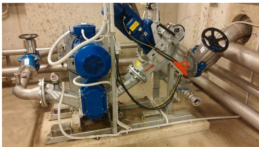
Obrázek 7: Mechanické mletí zahuštěného kalu (Zdroj: Autor, 2017)
