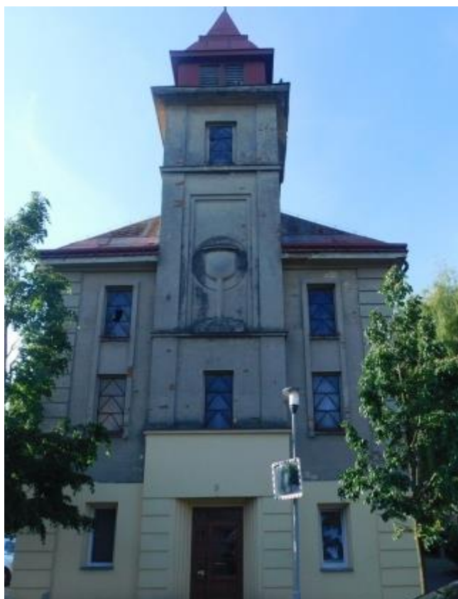
Obrázek 6: Pohled na vchod do bývalé kavárny.
