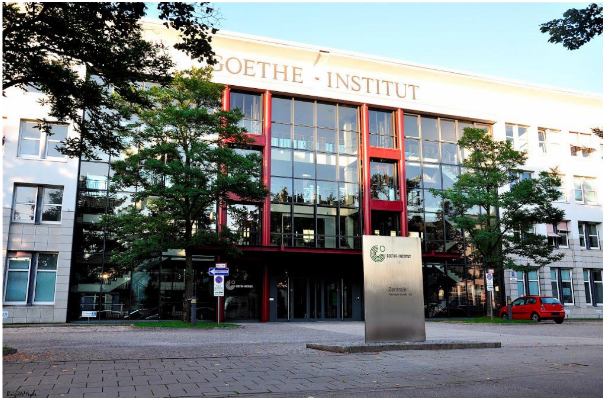
Bild Nr. 2 - Das Goethe-Institut in München (Dachauer Straße)
