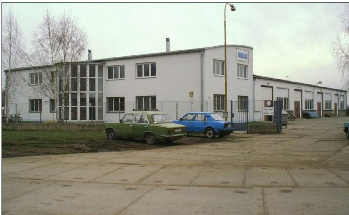
Příloha č. 5: Objekt pro praktickou výuku na ulici U Spalovny 12 (Výroční zpráva o činnosti SOU stavebního Prostějov 2010/2011)
