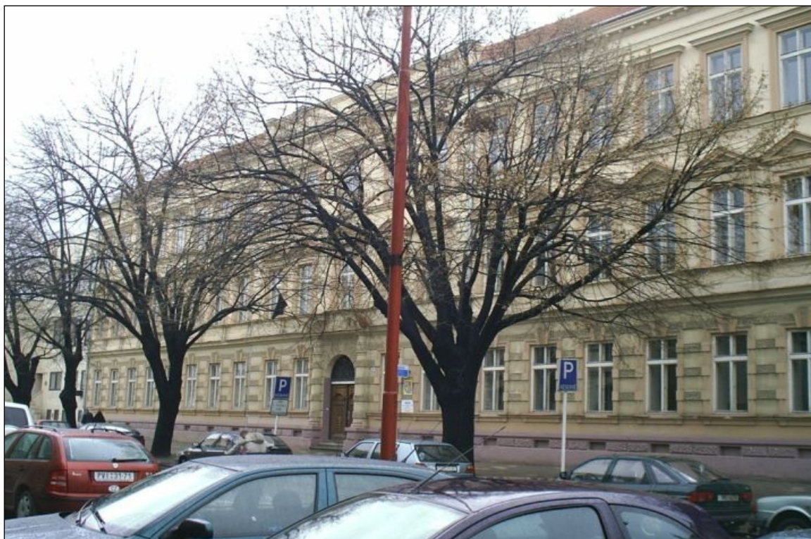
Příloha č. 4: Objekt pro teoretickou výuku na ulici Komenského 4 (Výroční zpráva o činnosti SOU stavebního Prostějov 2010/2011)
