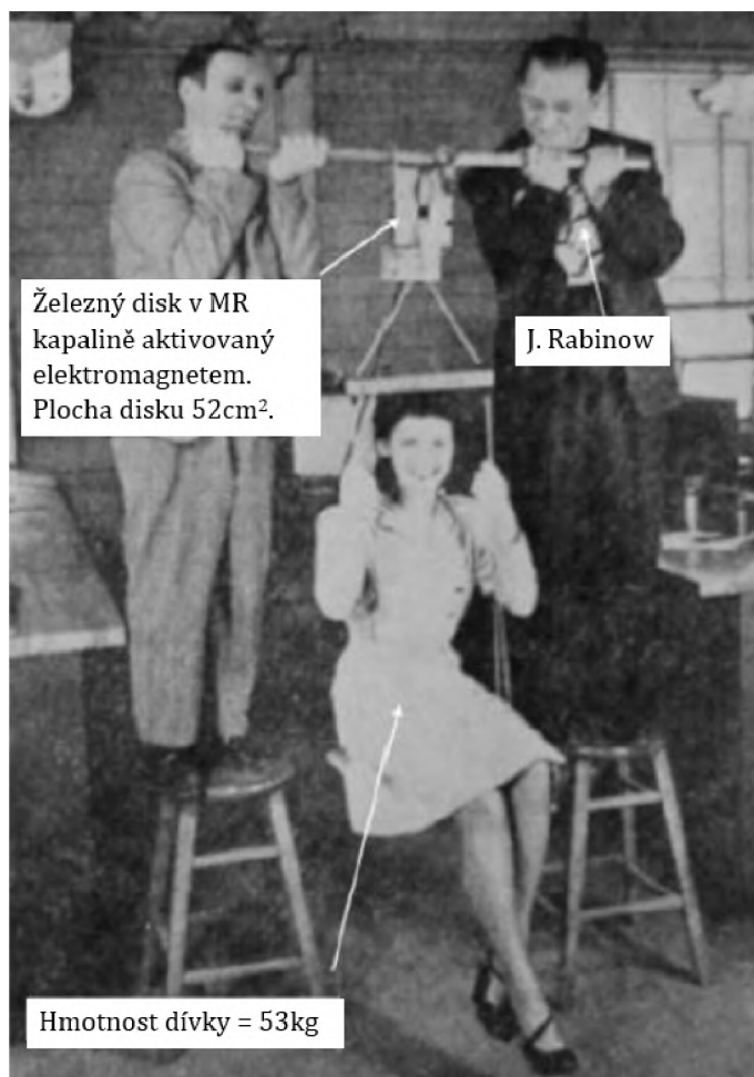
Obr. 3.1: Ing. Rabinow při demonstraci magnetoreologické kapaliny [25].
