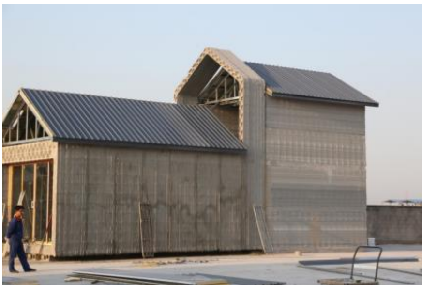
Obr. 20: Vytlačený funkčný jednopodlažný dom od spoločnosti WinSun (Zdroj 25)
